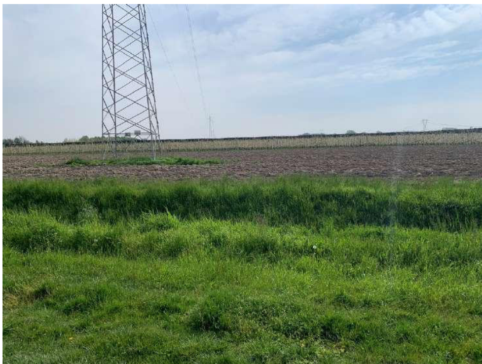
Confine Ovest - di fronte LOTTO 6 (traliccio elettrodotto)
