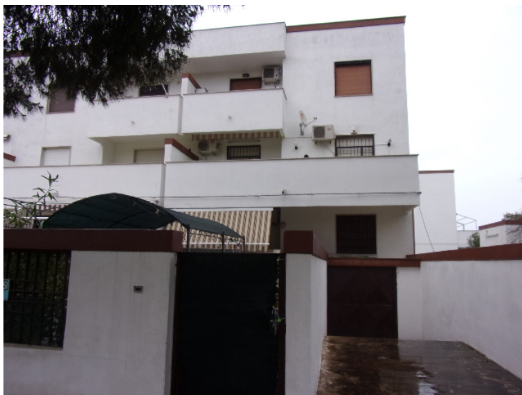
FOTO N°2 PROSPETTO PRINCIPALE RESIDENCE – LATO CORTE INTERNA
