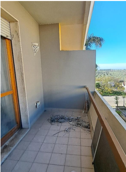
FOTO n.31 – CASA – balcone nord
