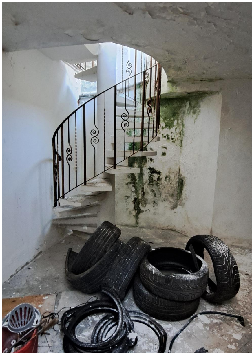
FOTO n.52 – GARAGE – spazio interno (zona non autorizzata) - scala a chiocciola che porta allo scoperto retrostante della casa a piano rialzato
