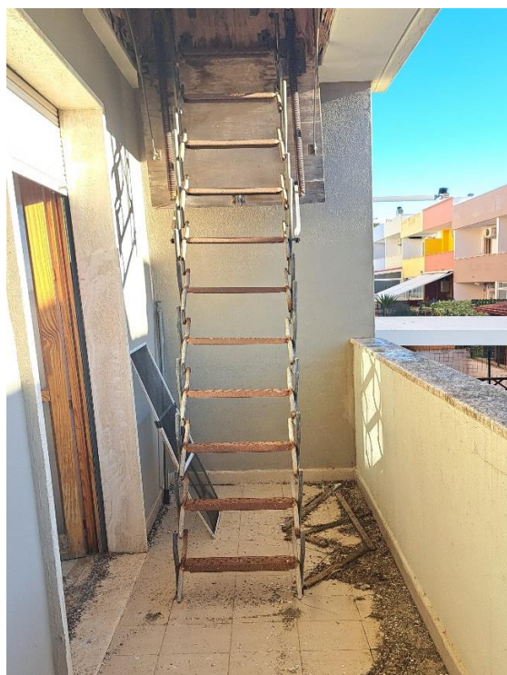
FOTO n.42 – CASA – balcone camerette
