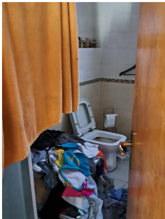
FOTO n.19 – CASA – bagno zona giorno
