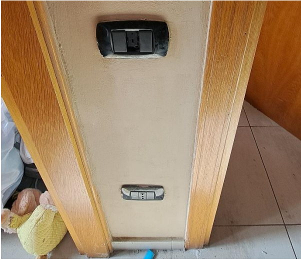
FOTO n.29 – CASA – particolare prese luce
