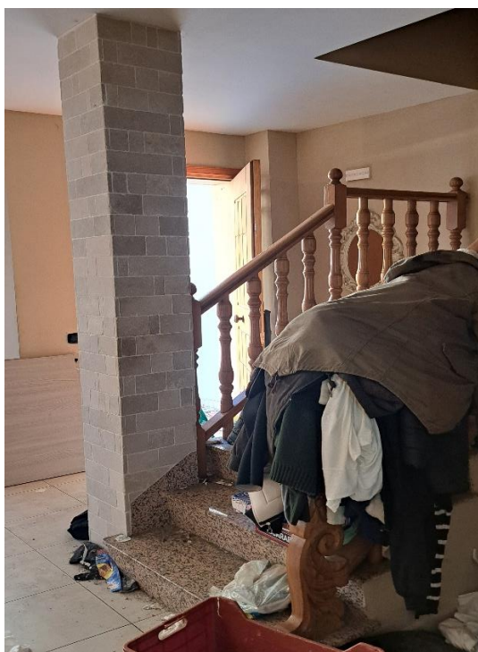
FOTO n.22 – CASA – scala centrale per P.P.
