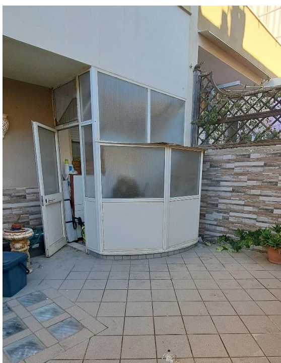
FOTO n.54 – struttura di copertura della scala
