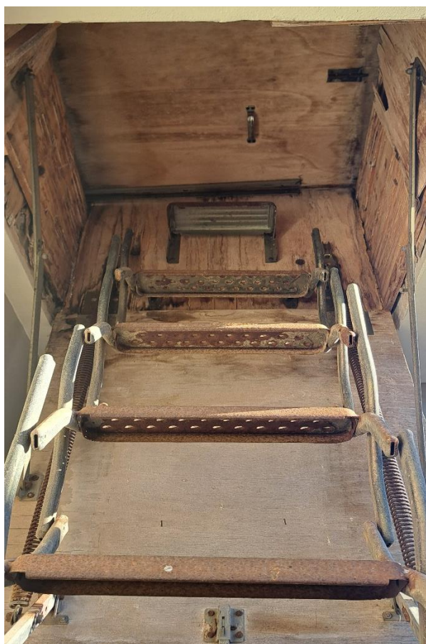
FOTO n.42 – CASA – botola accesso al lastricato solare
