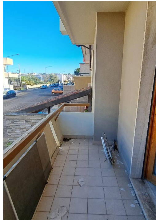
FOTO n.32 – CASA – balcone nord
