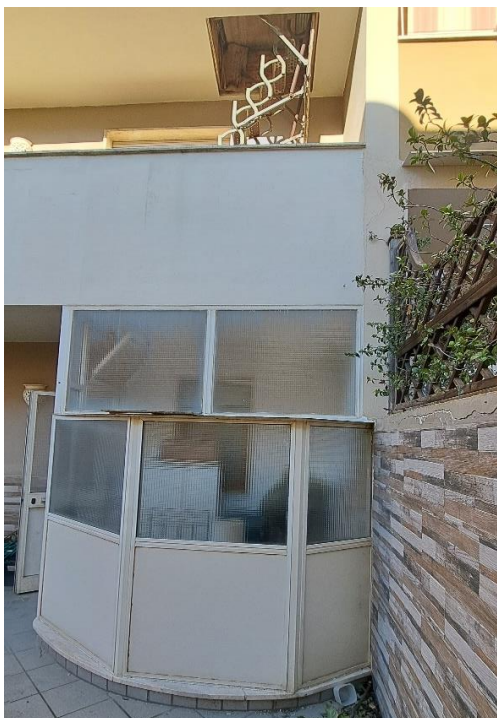
FOTO n.56 - struttura di copertura della scala
