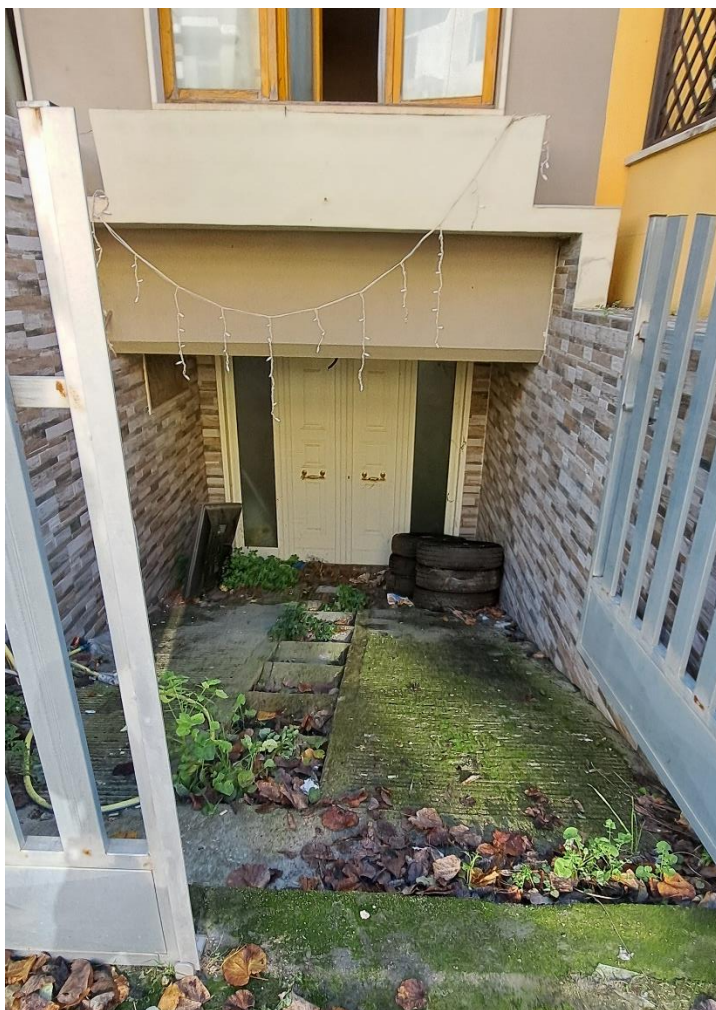
FOTO n.5 – GARAGE- via Volturmo n.63/A ingresso carraio
