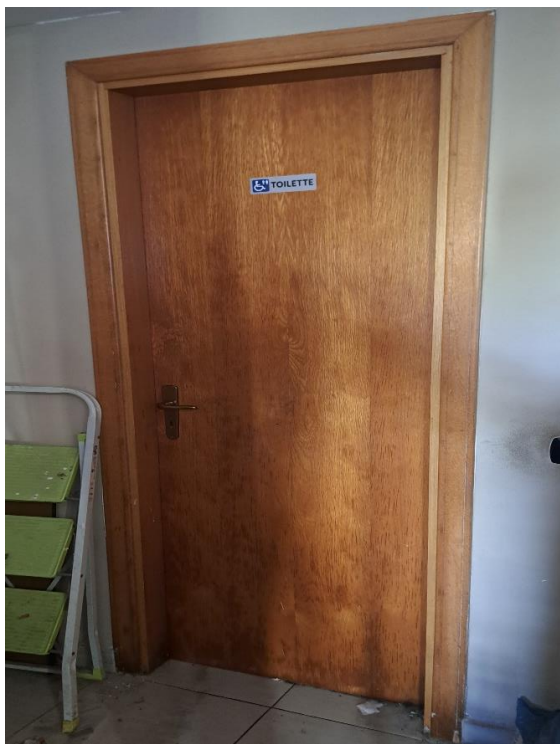
FOTO n.18 – CASA – bagno zona giorno
