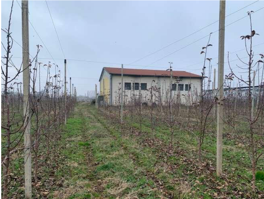
Mapp 434 – confine sud e prospetto sud capannone
