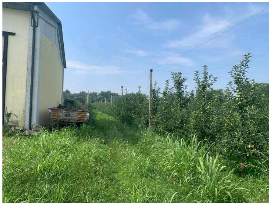
Mapp 434 – Confine ovest e prospetto ovest capannone
