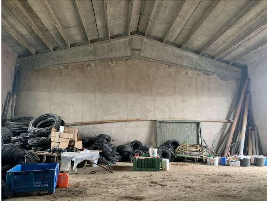
Mapp 434 – capannone – testata ovest - interno
