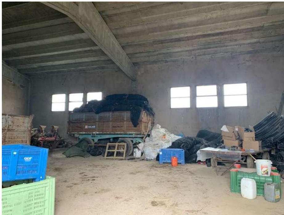
Mapp 434 – capannone – parete longitudinale sud - interno
