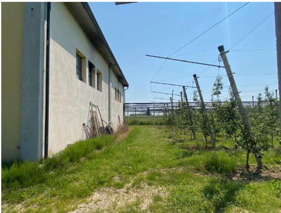
Mapp 434 – confine est e prospetto est capannone
