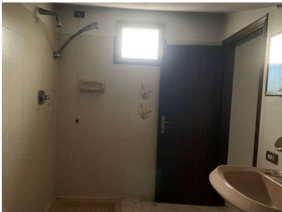
Mapp. 192 sub 1 - Sottotetto - Bagno da rimuovere -
