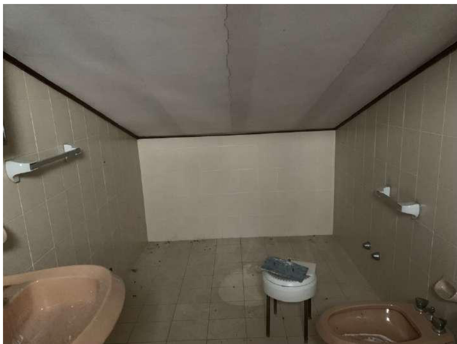
Mapp. 192 sub 1 - Sottotetto - Bagno da rimuovere -
