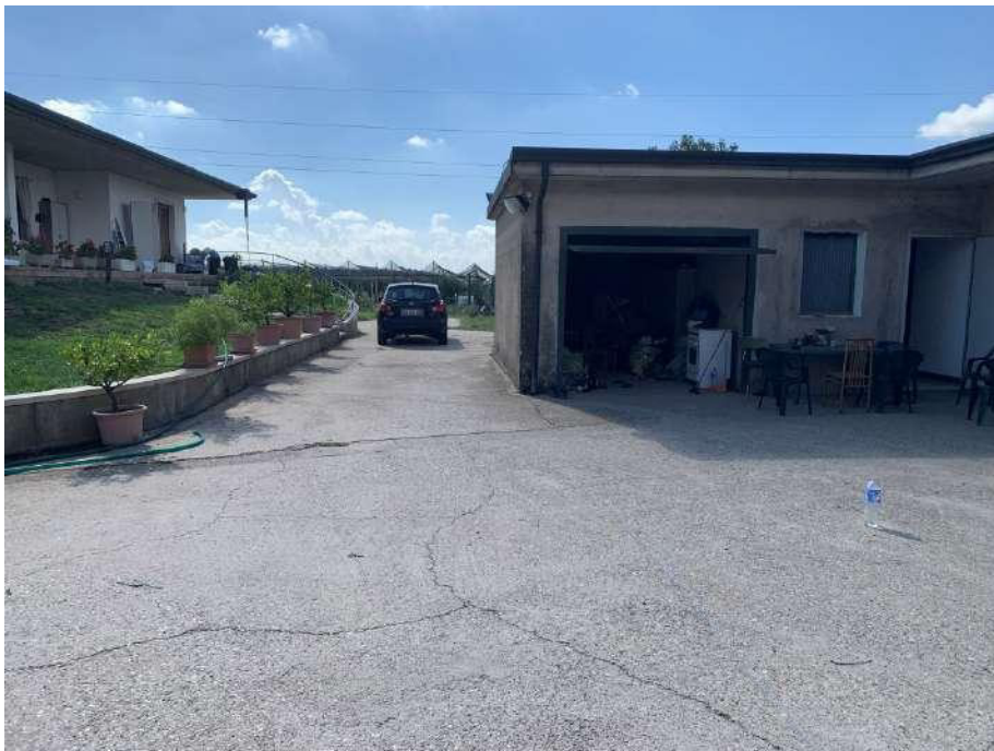
Mapp. 491 - Locale deposito 4
