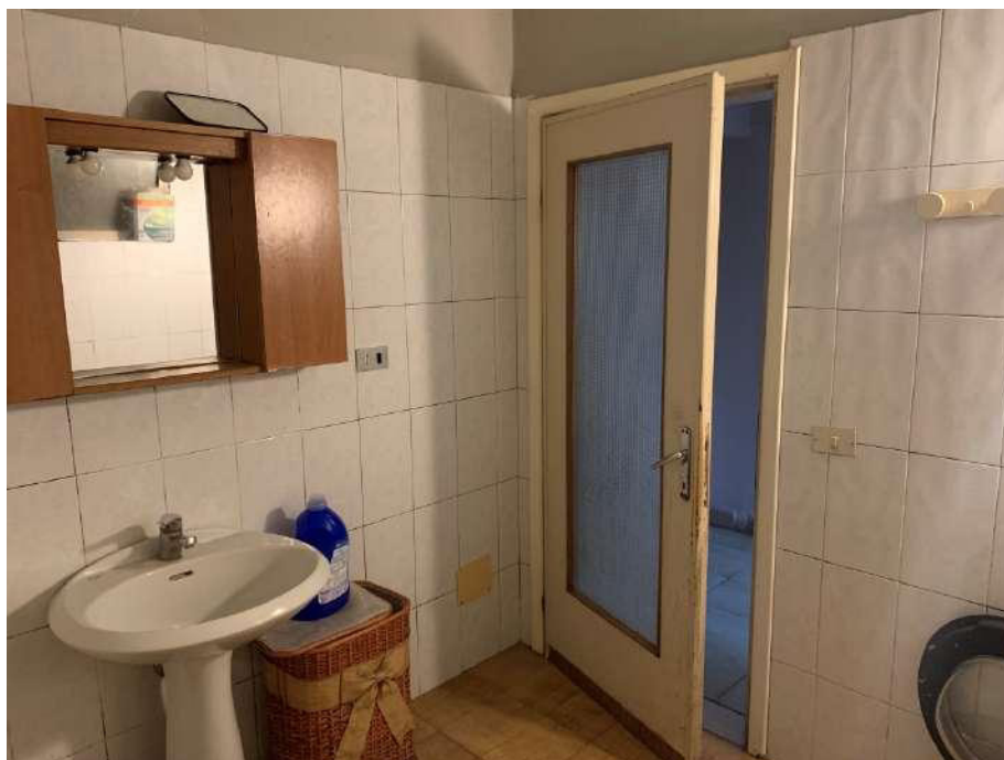
Mapp. 491 - Bagno 1 da ripristinare come da progetto
