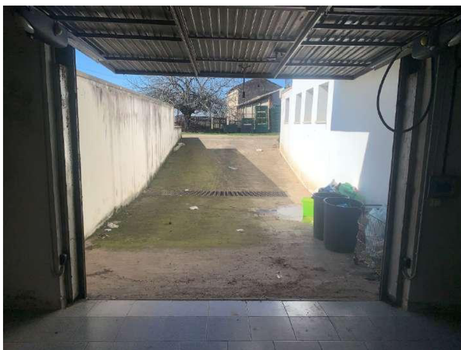
Mapp. 192 sub 2 - Ricovero Attrezzi (Locale 1 – rampa in uscita)
