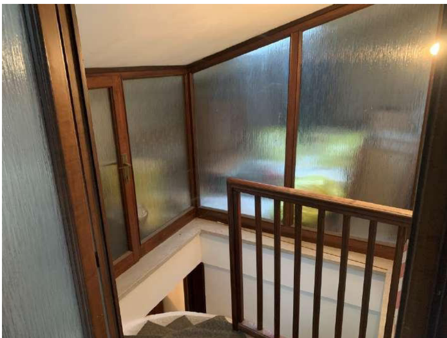
Mapp. 192 sub 1 - Piano Terra/Rialzato: Scala per sottotetto da sanare
