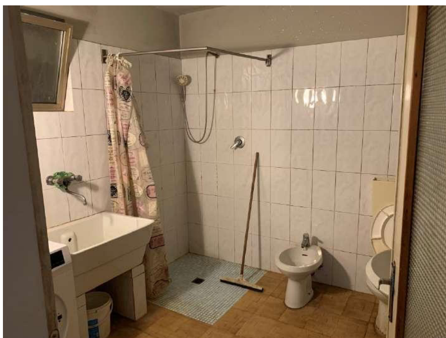
Mapp. 491 - Bagno 1 da ripristinare come da progetto
