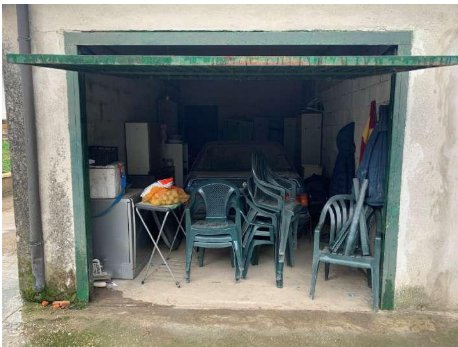
Mapp. 491 - Locale deposito 4
