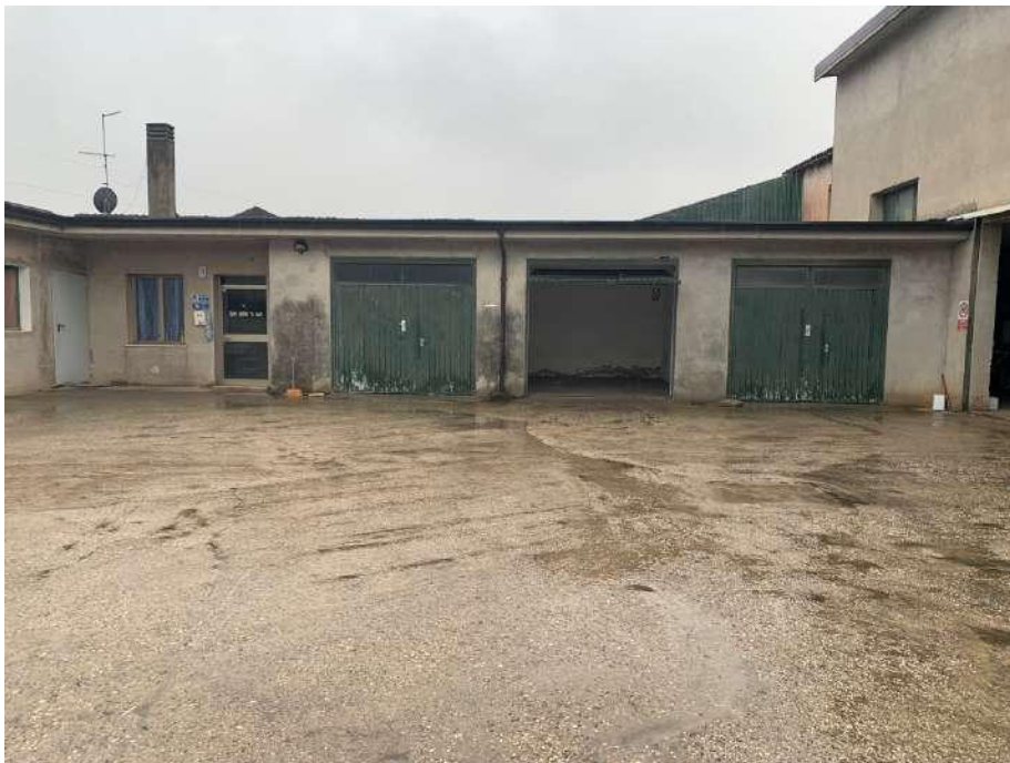
Mapp. 491 - Locali deposito 1 - 2 - 3
