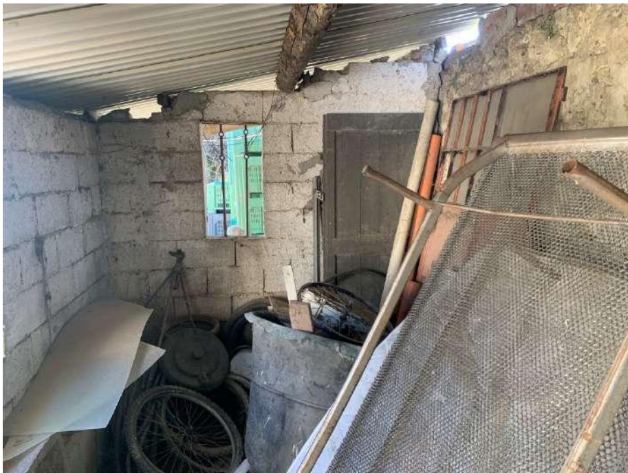
Mapp. 491 - Locale deposito 5
