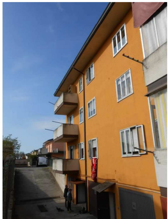
Vista della rampa e retro garage
