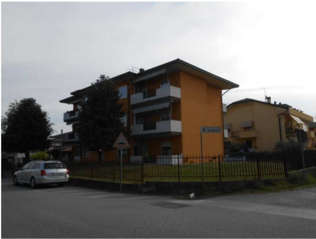
Prospetto ovest principale su Via Tombole
