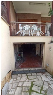
FOTO 38 – ACCESSO AL PIANO SEMINTERRATO
