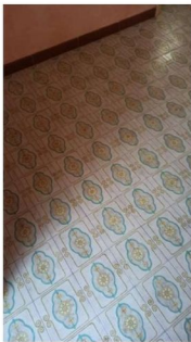
FOTO 30 – DETTAGLIO PAVIMENTAZIONE PIANO 1°
