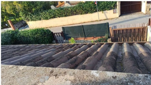
FOTO 33 – VISTA DA BALCONE PIANO 1°
