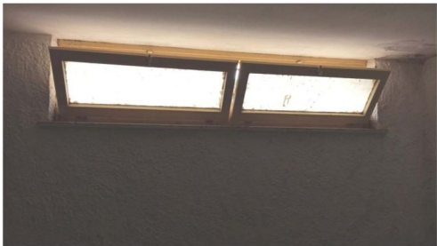
FOTO 45 – DETTAGLIO INFISSO PIANO SEMINTERRATO
