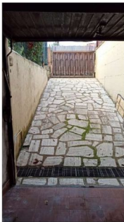
FOTO 39 – RAMPA DI ACCESSO AL PIANO SEMINTERRATO
