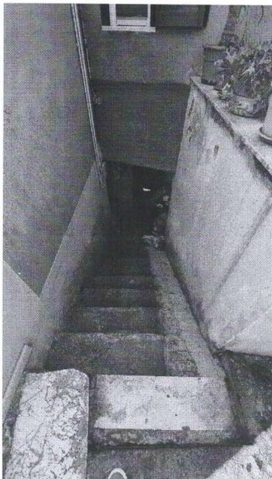
Foto n.22: rampa di accesso al locale cantina
