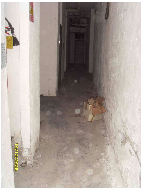
Vano condominiale – P.S1
