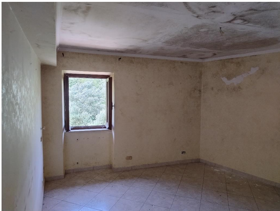
Piano primo - camera con balcone (foto del 25/07/2025)
