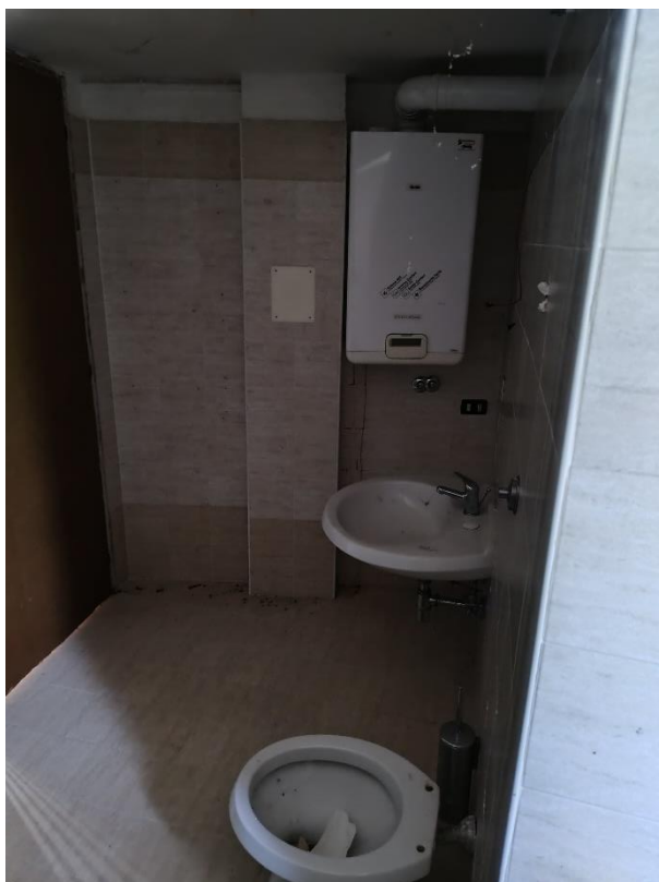
Piano seminterrato - bagno (foto del 25/07/2025)
