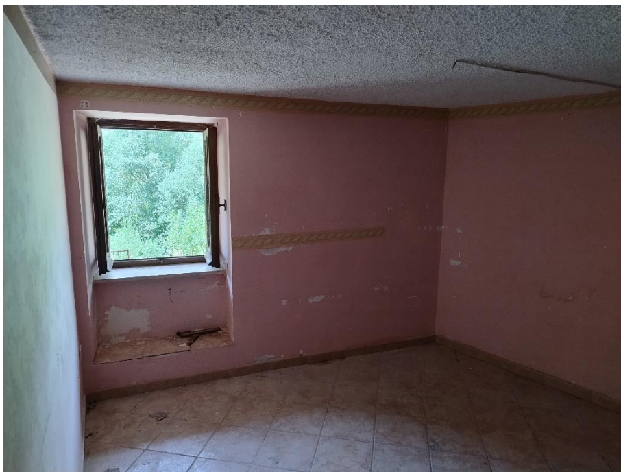
Piano seminterrato - camera (foto del 25/07/2025)
