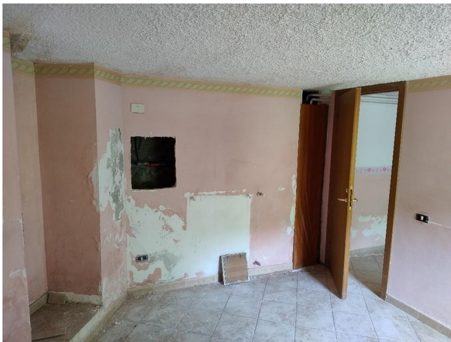
Piano seminterrato - camera (foto del 25/07/2025)
