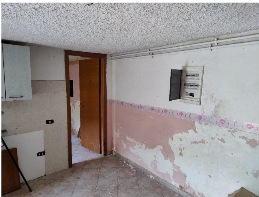
Piano seminterrato - cucina (foto del 25/07/2025)
