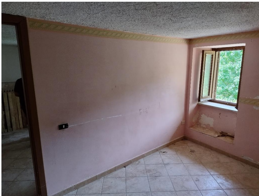
Piano seminterrato - camera (foto del 25/07/2025)
