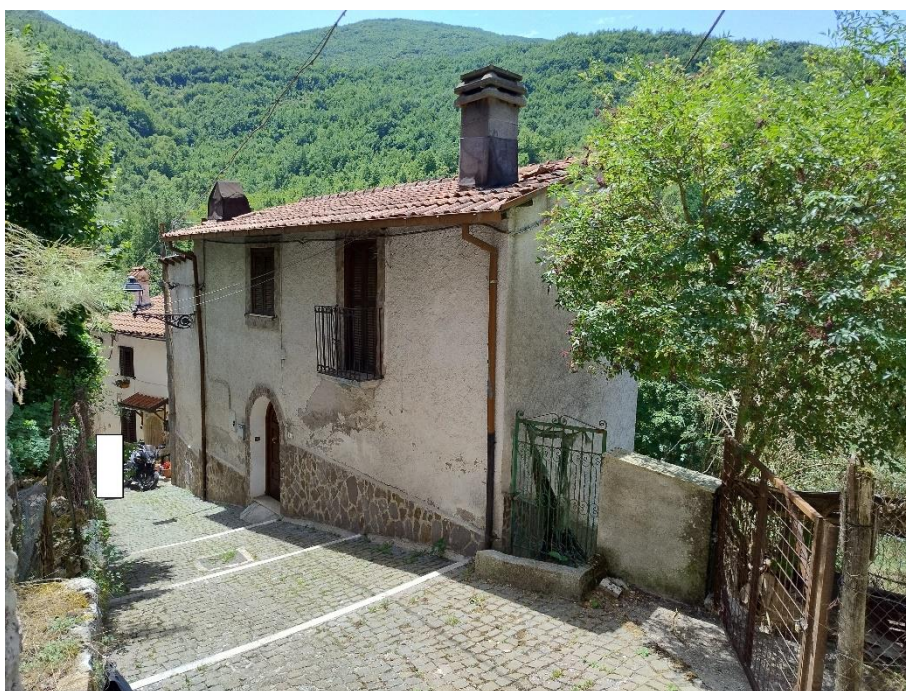
Prospetto <<...omissis...>> lato nord-est (foto del 25/07/2025)
