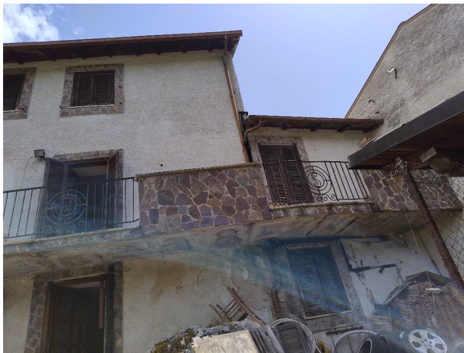
Prospetto su lato ovest (foto del 25/07/2025)
