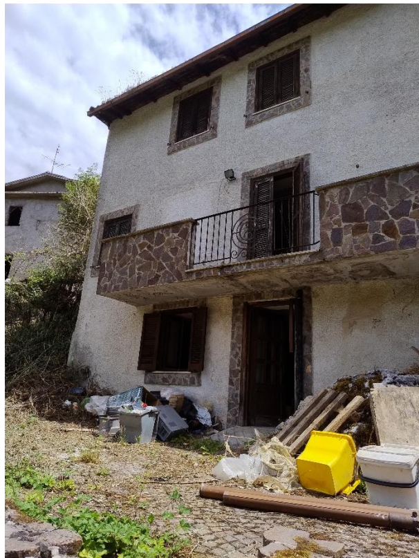
Prospetto su lato ovest (uscita su terreno non di proprietà) (foto del 25/07/2025)
