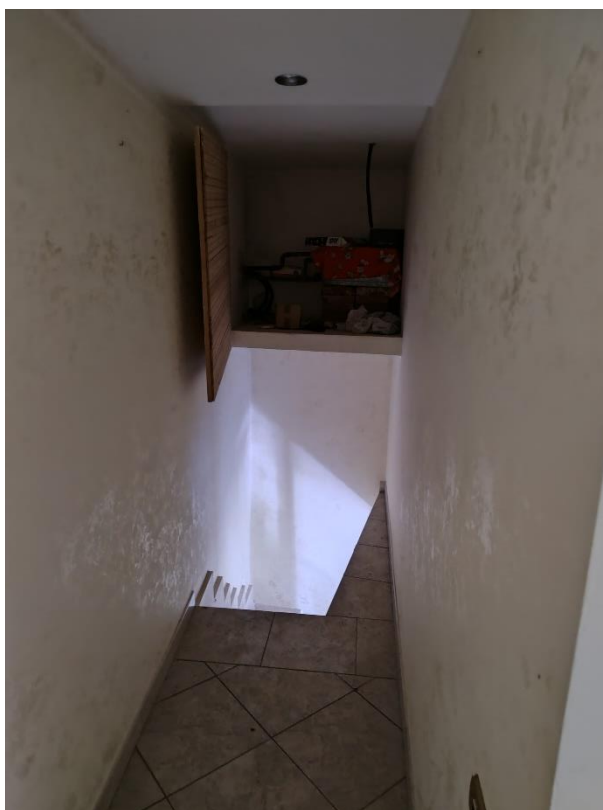
Piano primo - corridoio lato scala (foto del 25/07/2025)
