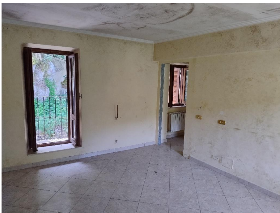
Piano primo - camera con balcone (foto del 25/07/2025)
