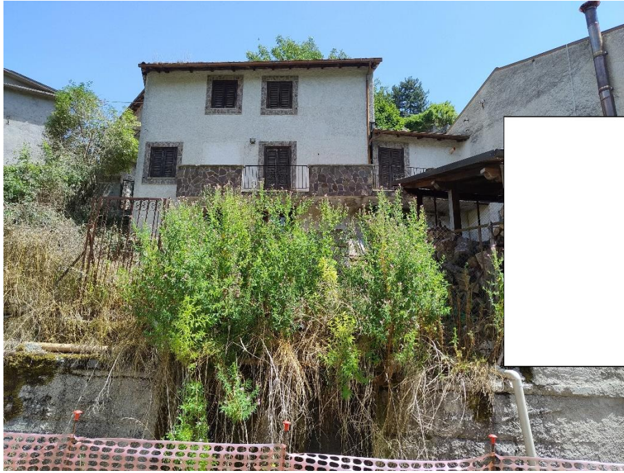
Prospetto su lato ovest (foto del 25/07/2025)
