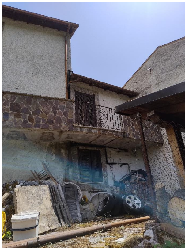
Prospetto su lato ovest (foto del 25/07/2025)
