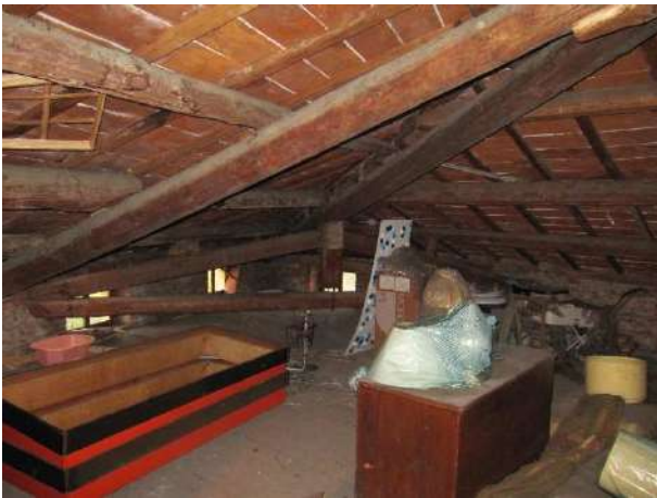
Vista piano terzo
