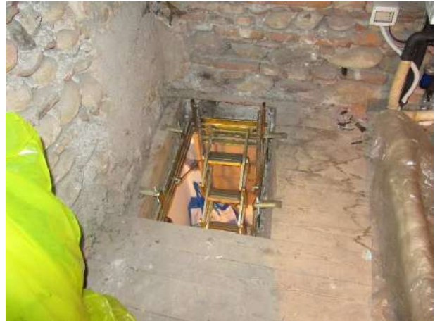
Vista botola ingresso piano terzo
