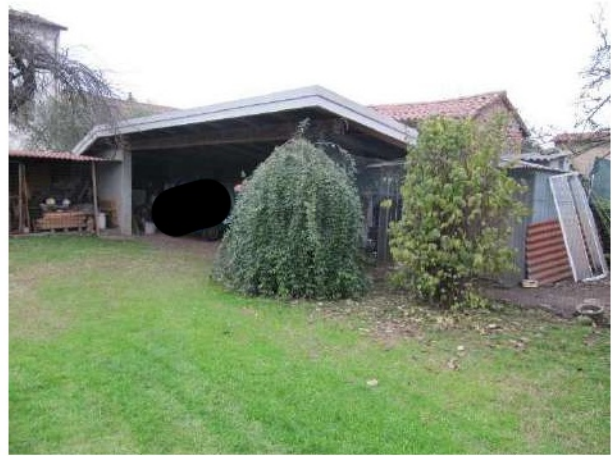
Vista esterna sub 8 da demolire
