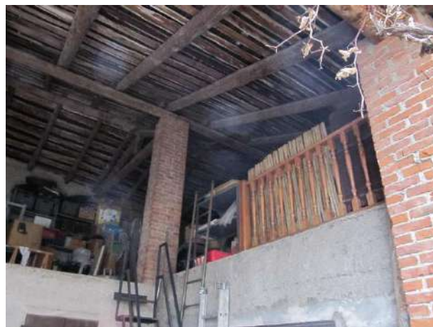
Vista locale di deposito
