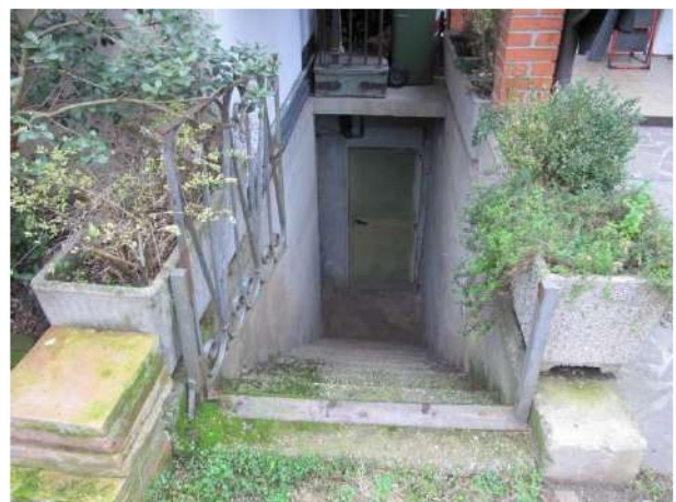
Vista ingresso piano interrato
