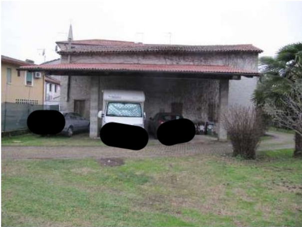
Vista esterna sub 7
