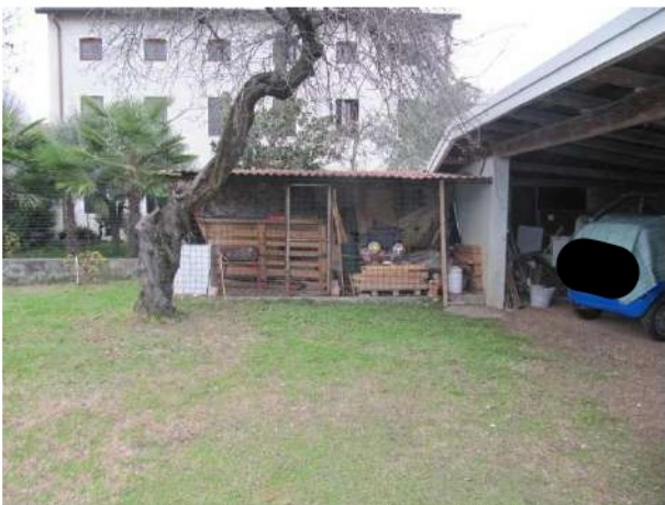
Vista esterna sub 8 da demolire
