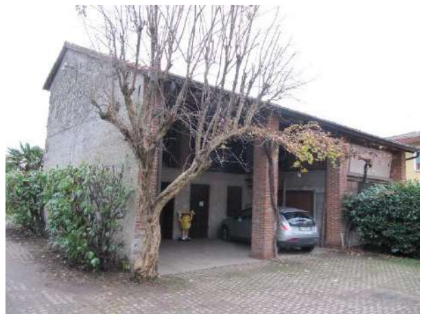
Vista esterna sub 7
