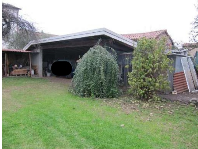
Vista rimessa - da demolire
