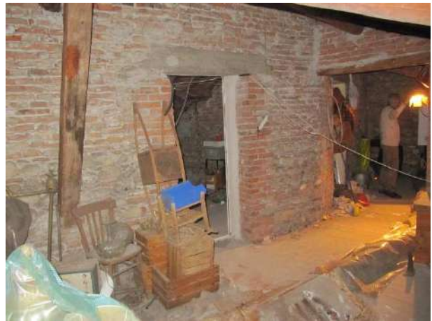
Vista piano terzo
