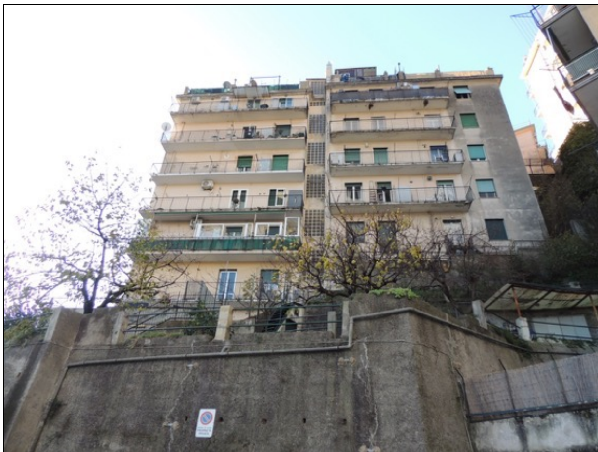
Foto 5 – il fabbricato civico 39 A di via delle Gavette
