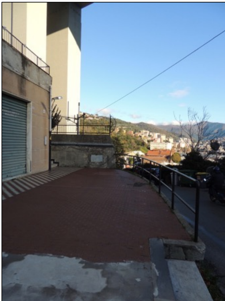
Foto 11 – il distacco da via delle Gavette 39 A che conduce alla scala di accesso al condominio, al centro della foto
