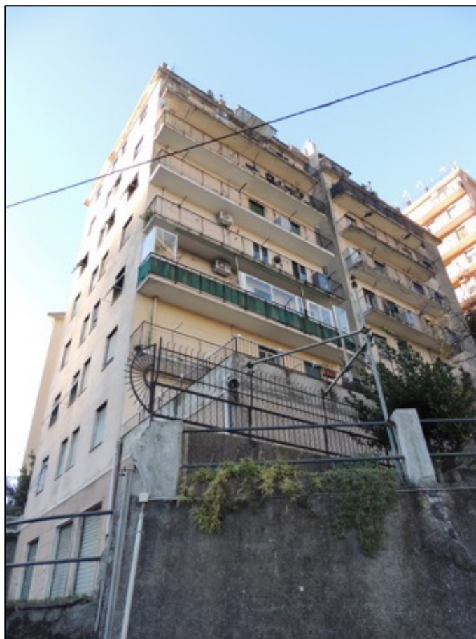
Foto 6 – il fabbricato civico 39 A di via delle Gavette
