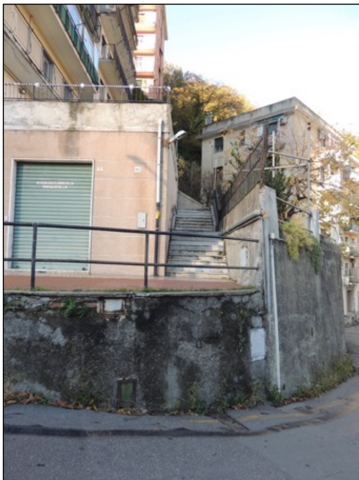
Foto 12 – la scala di accesso al condominio, al centro della foto;
