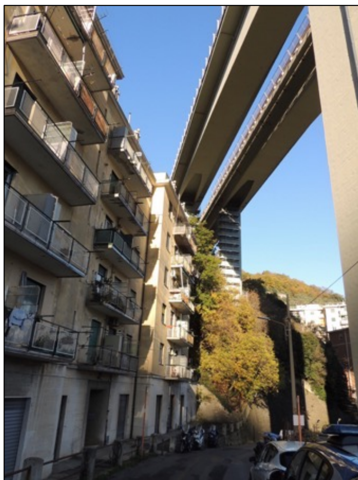
Foto 2 – vista di via delle Gavette verso il basso. Il viadotto autostradale che sovrasta la via,
