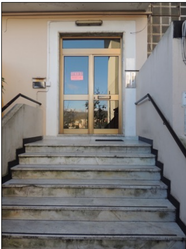
Foto 14 – il portone di accesso al civico 39 A di via delle Gavette situato al piano primo del fabbricato;
