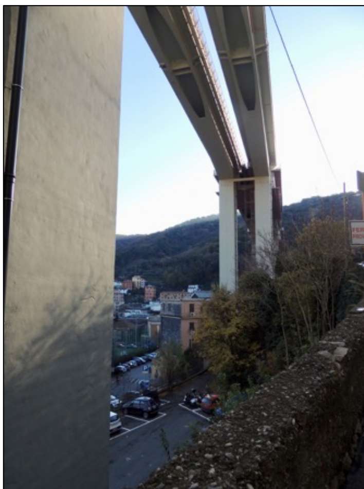
Foto 4 – vista dalla via sul viadotto autostradale
