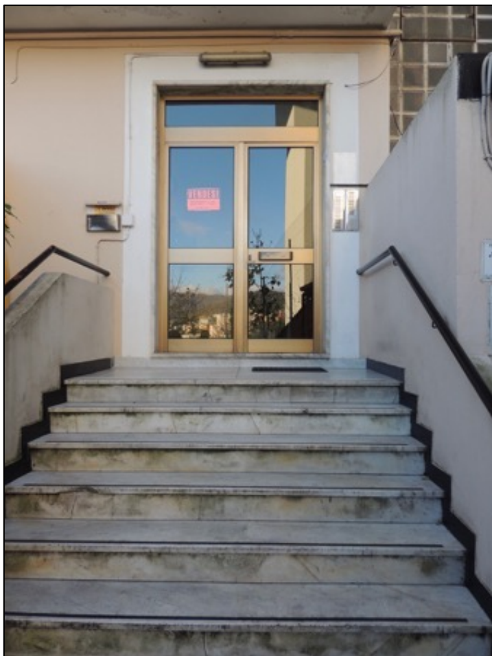
Foto 1 – il portone di accesso al civico 39 A di via delle Gavette situato al piano primo del fabbricato;
