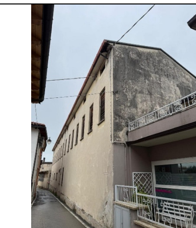
Foto 6. Vista (esterna) sud/est (fg. 5 – mn. 516/1)
