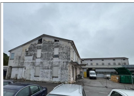
Foto 1. Vista (esterna) nord (fg. 5 – mn. 516/1)
