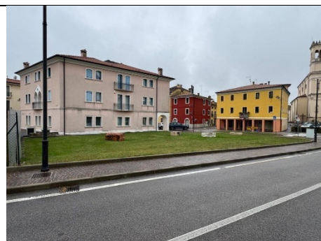
Foto 14. Vista (esterna) est (fg. 5 – mn. 817-1337..)
