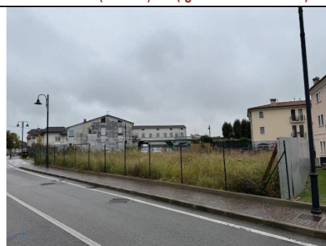
Foto 16. Vista (esterna) est (fg. 5 – mn. 817-1337..)
