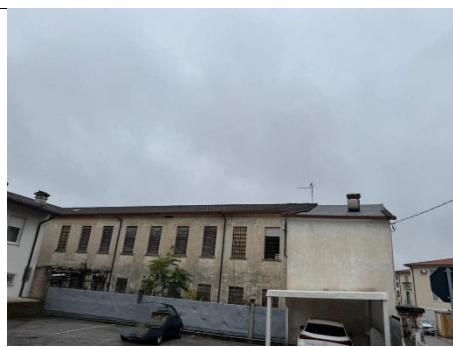
Foto 4. Vista (esterna) est (fg. 5 – mn. 516/1)
