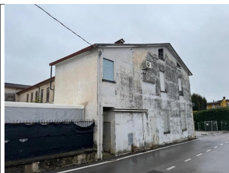
Foto 3. Vista (esterna) nord/est (fg. 5 – mn. 516/1)
