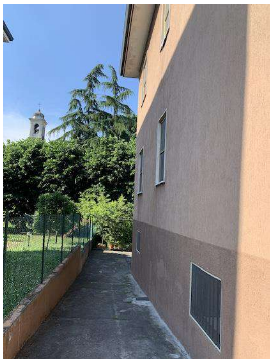
Foto 7: RECINZIONE LATO OVEST
