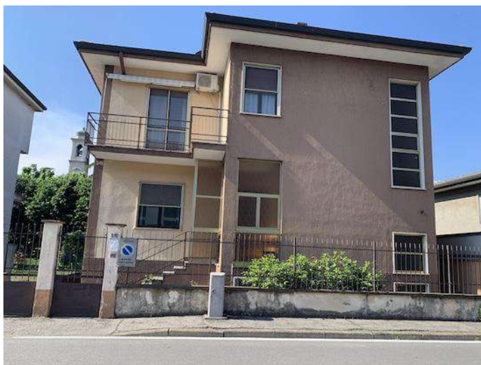
Foto 2: IMMOBILE DA STRADA
