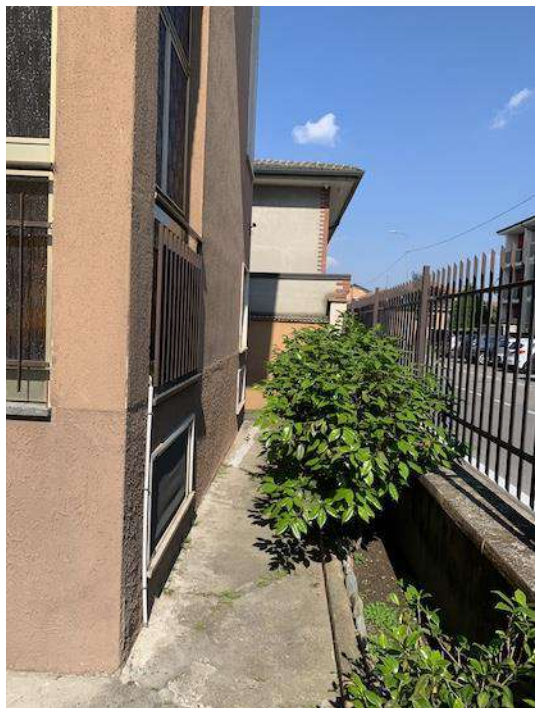
Foto 5: RECINZIONE LATO STRADA
