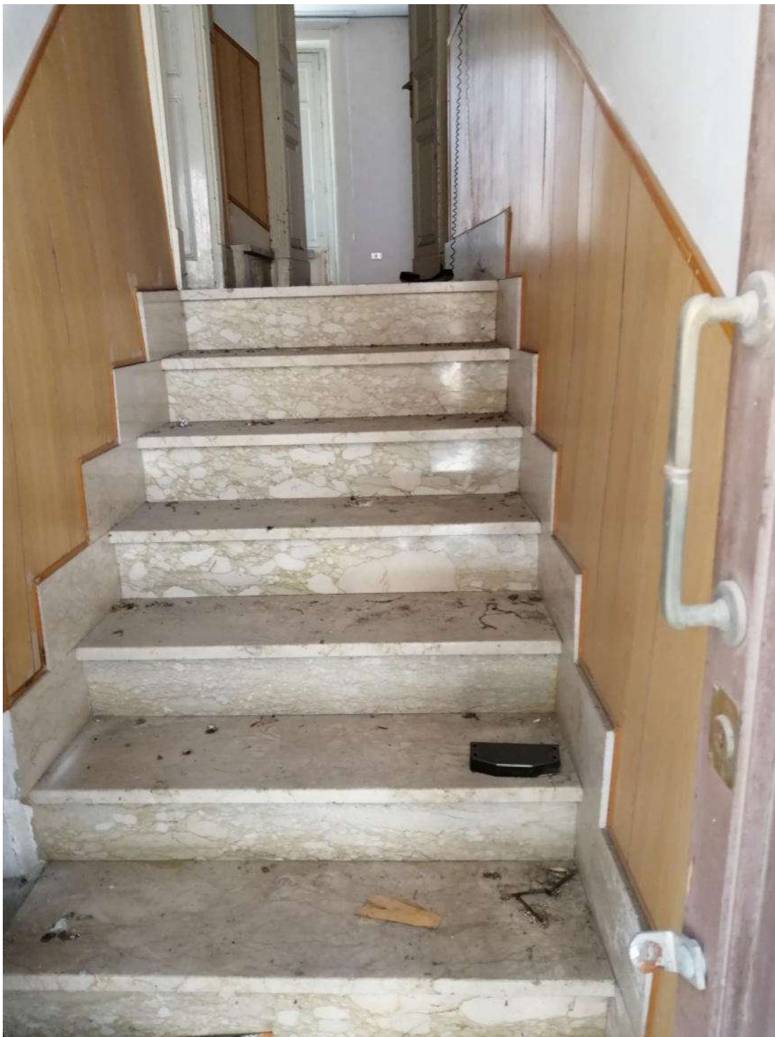
Foto N. 1(Vano scala che porta al Piano Primo)
