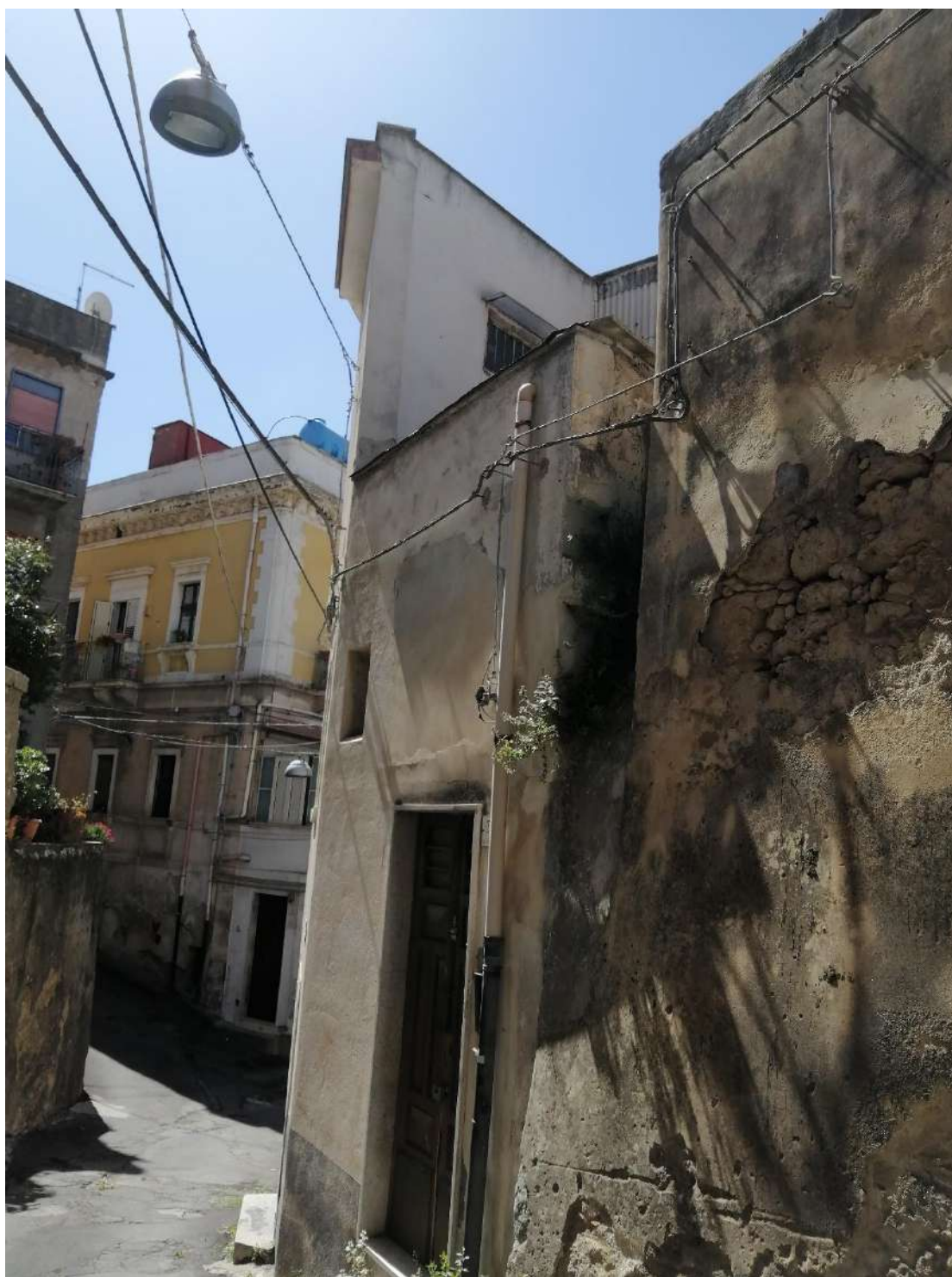
Foto N. 1 (Prospetto con porta d'ingresso che permette l'accesso all'immobile)
