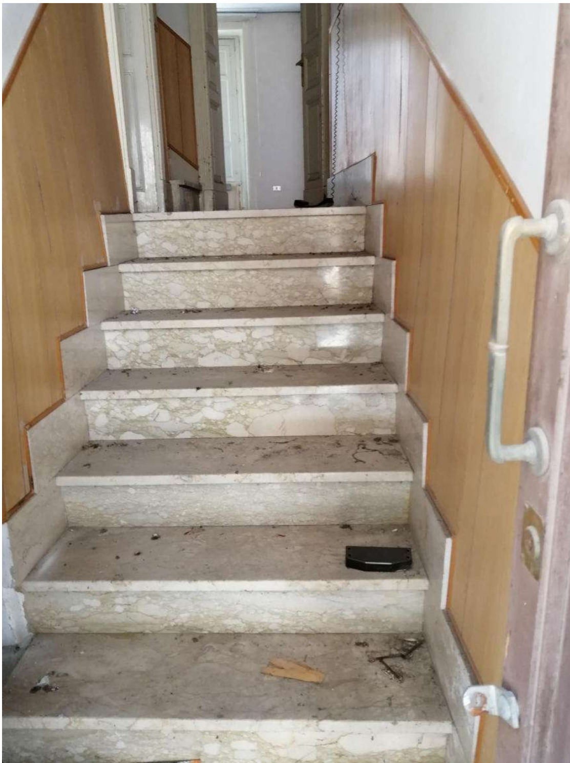
Foto N. 1(Vano scala che porta dal piano terra al piano primo)
