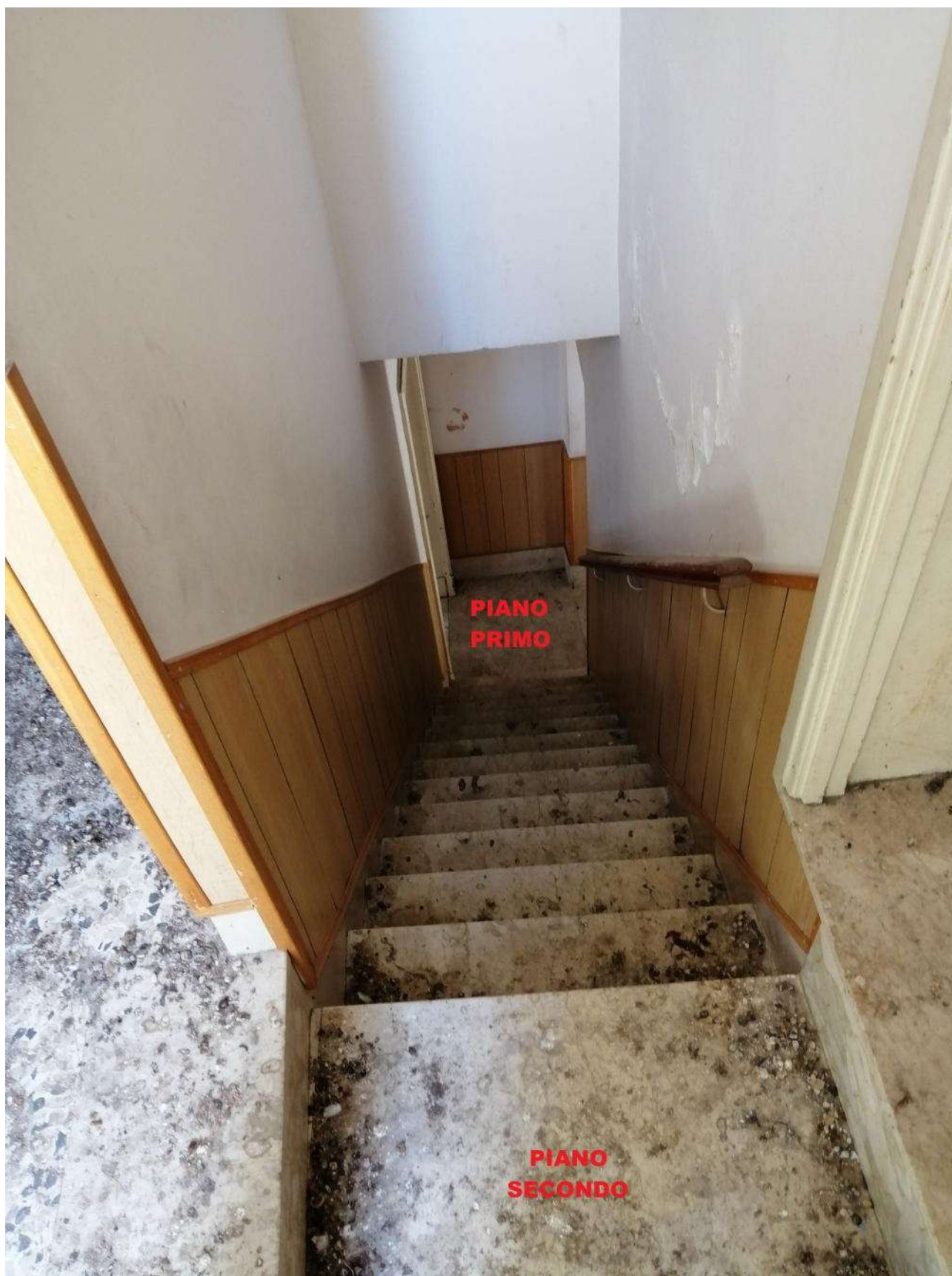
Foto N. 2 (Vano scala che porta dal piano primo al piano secondo)
