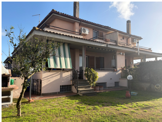
Giardino annesso all'immobile
