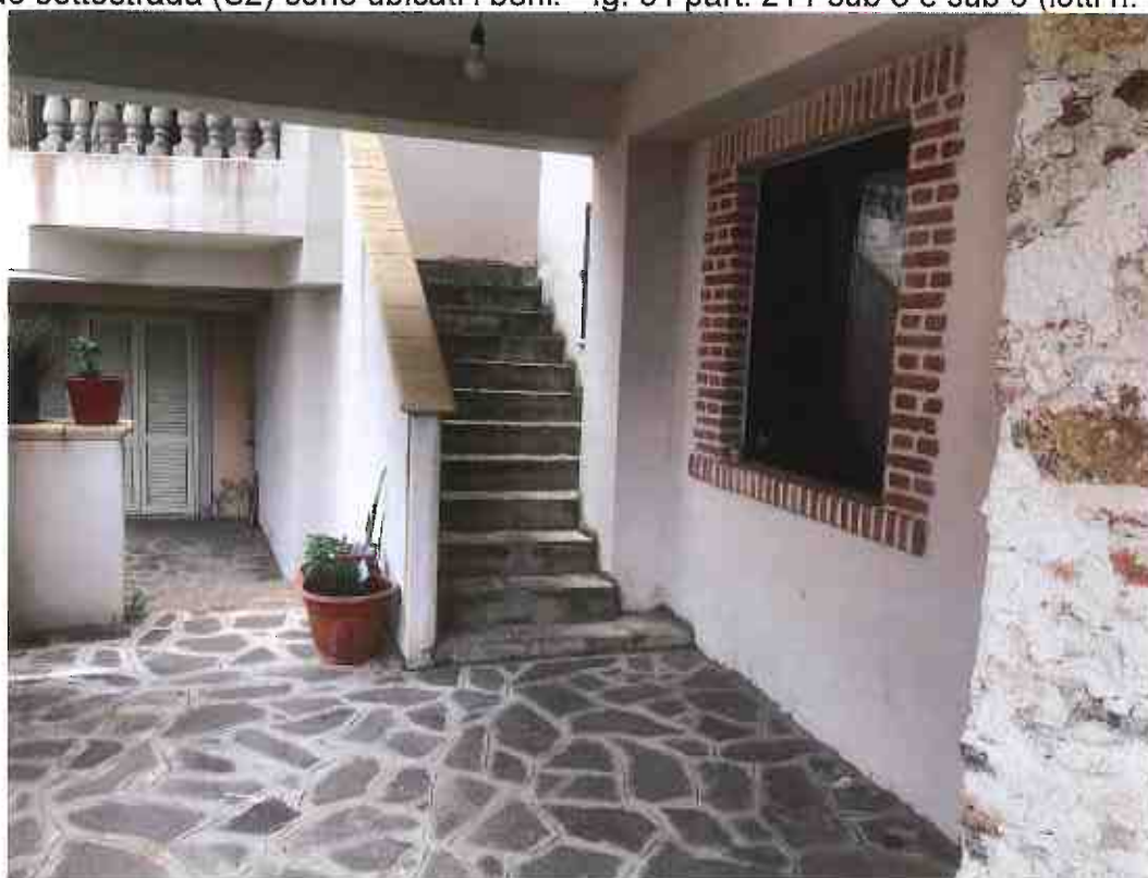
Foto 64 – Unità (ad uso cucina, bagno, ripostiglio) - fg. 34 part. 211 sub 5: scala di accesso dalla via pubblica e finestra in luogo dell'originaria porta d'ingresso (lotto n. 8)
