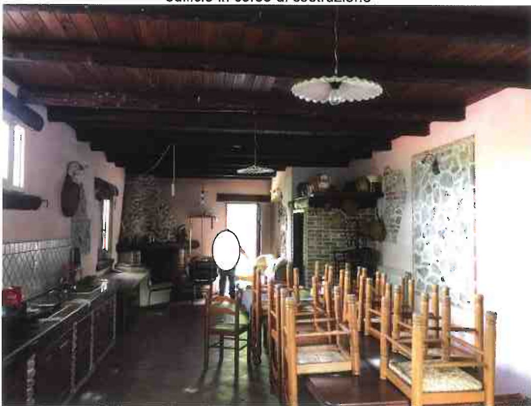
Foto 78–Terreno con fabbricati Argusto (lotto n. 10): interno p. S1 edificio in corso di costruz.
