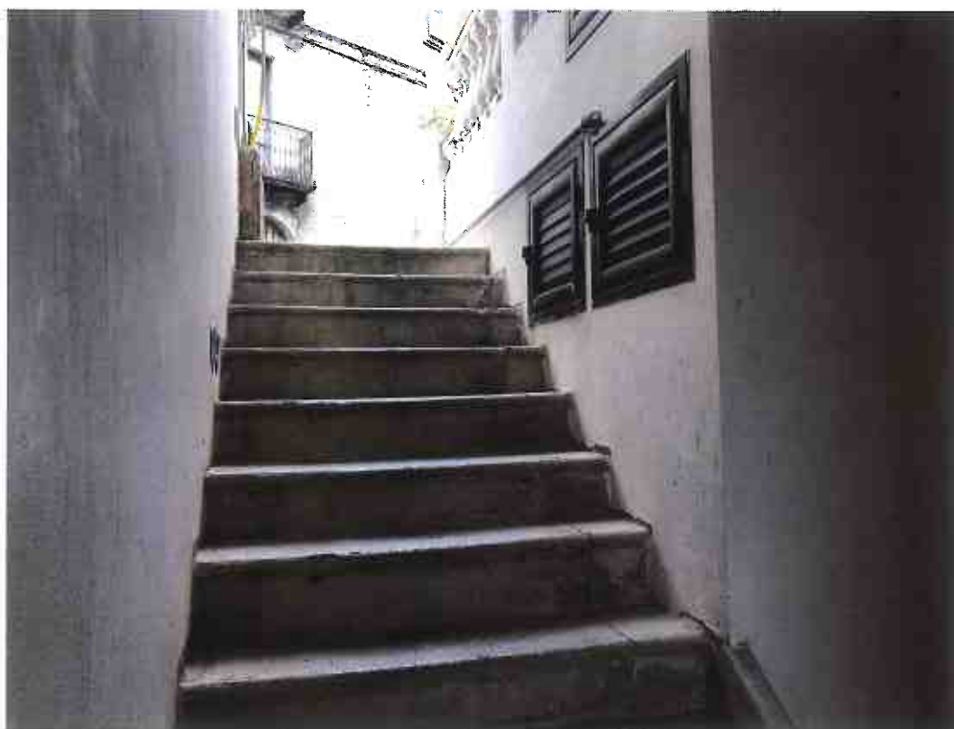
Foto 55 – Abitazione identificata con fg. 34 part. 211 sub 7: scala di accesso dalla via pubblica (lotto di vendita n. 7)
