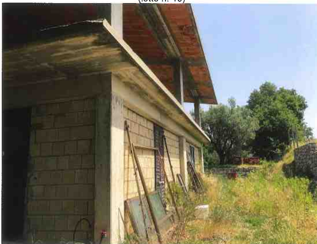
Foto 72 – Terreno in Argusto con entrostanti fabbricati (lotto n. 10): edificio in corso di costruzione
