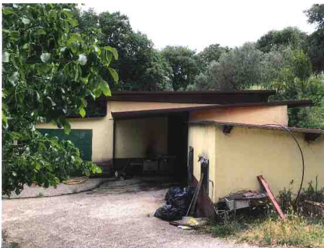
Foto 83 – Terreno con fabbricati in Argusto, loc. “Castagnara” (lotto n. 10): stalla con locale accessorio laterale ed antistante manufatto – porcilaia
