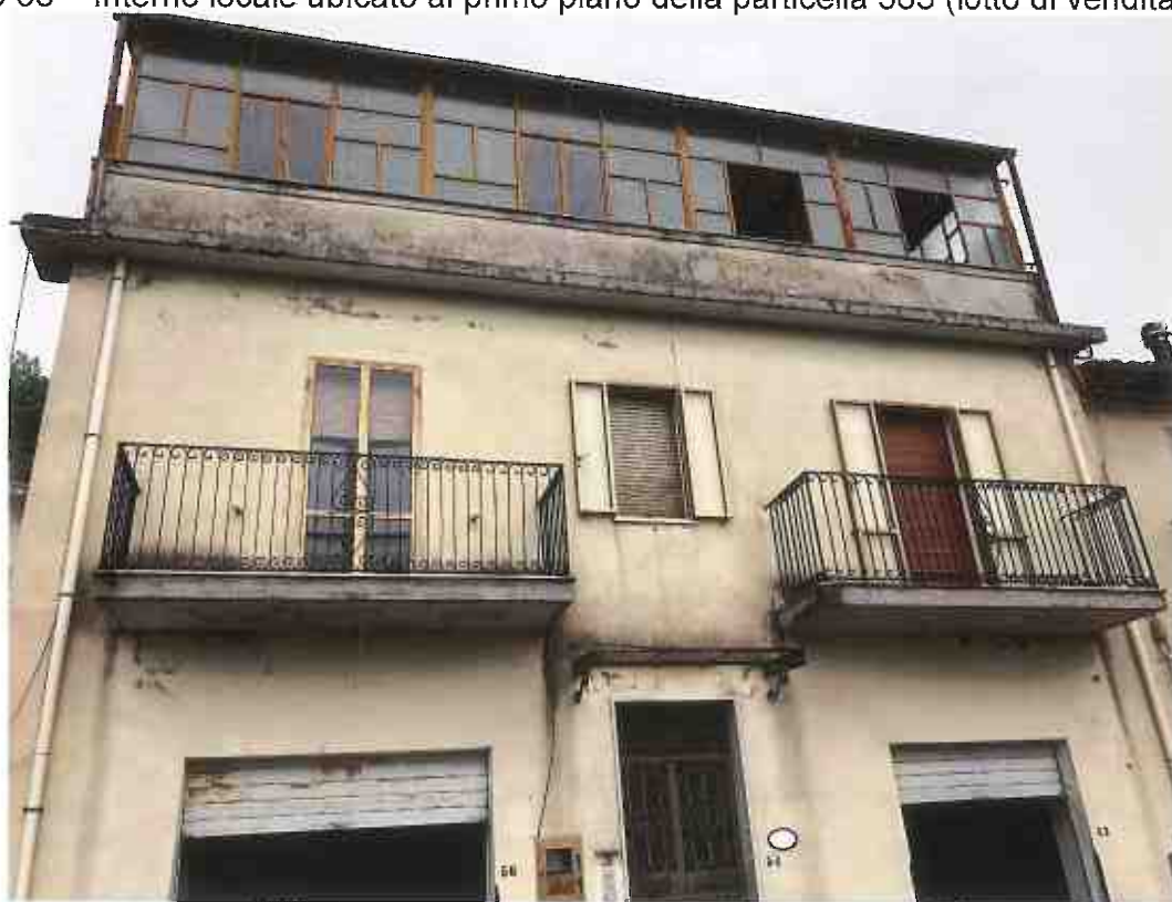
Foto 34 – Fabbricato in Chiaravalle C.le destinato ad abitazione e magazzini / box auto prospiciente la via Nazionale: fg 34 part. 562 (lotto di vendita n. 3)
