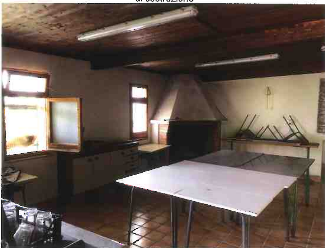
Foto 82 – Terreno con fabbricati Argusto: interno corpo avanzato dell'edificio in c.so costruz.
