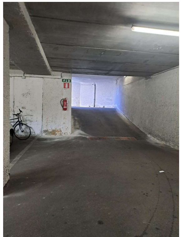
corsello di ingresso
