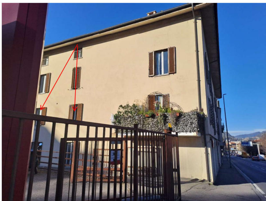
vista dal marciapiede
