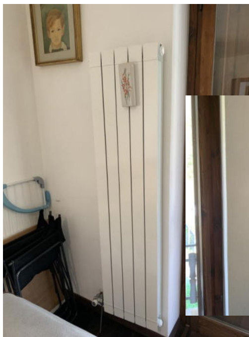
Impianto di riscaldamento autonomo con elementi radianti in alluminio
