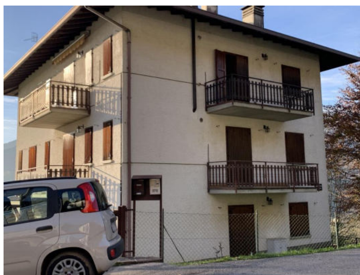
Vista dalla strada – via Locatelli
