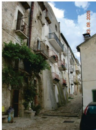
02-Esterni del cespite
