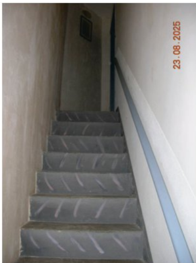
19-Scalinata per piano primo
