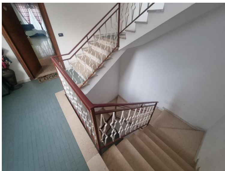
Foto 2 – Vano scala comune
