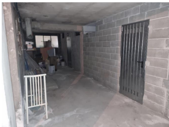
Foto 13 – Corridoio comune cantine
