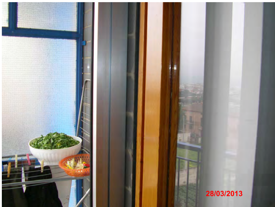
10 - Particolare infissi esterni (3)
