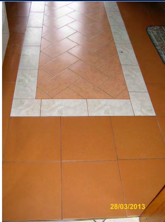
17 - Interno proprietà [REDACTED]: pavimento cucina
