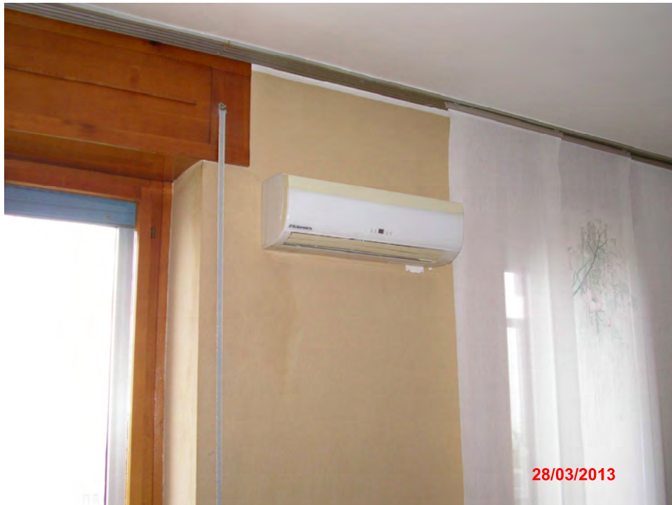
6 – Particolare infissi esterni (2)
