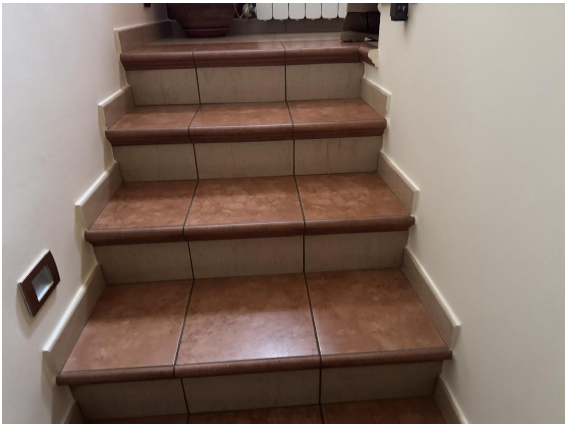
Scala collegamento Piano Terra/Piano I Seminterrato
