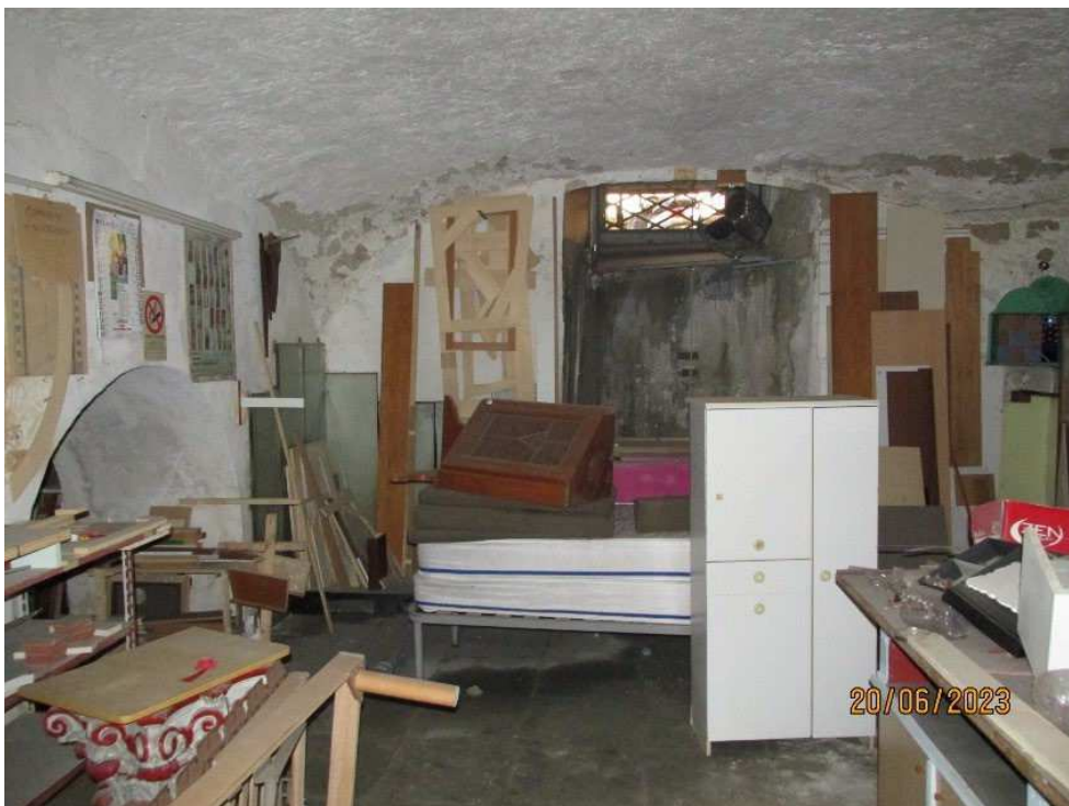
Fotografia 22 – Locale 2: L'ambiente dispone di una lustriera a “bocca di lupo” prospiciente la strada pubblica di Vico Sant'Eframo Vecchio. L'ambiente si presenta in un totale stato di abbandono, occupato da diversi mobili e materiali di ogni genere, le pareti mostrano segni diffusi di efflorescenze di macchia di umidità da risalita, anche il soffitto presenta diffuse macchie di umidità con fenomeni di distacco dello strato superficiale degli intonaci.
