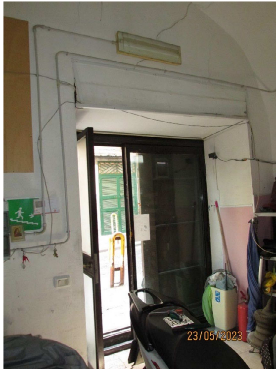
Fotografia 15 – Locale 1: le pareti sono interamente rivestite con intonaci ordinari a finitura liscia e tinteggiate con pittura lavabile; il soffitto è costituito da una volta a “botte” ed è intonacato e tinteggiato con pittura a tempera.
