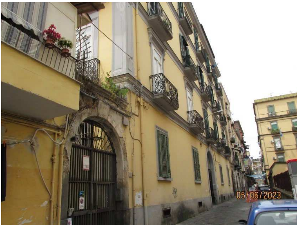
Fotografia 6 – Vista fabbricato da Via Sant'Eframo Vecchio.
