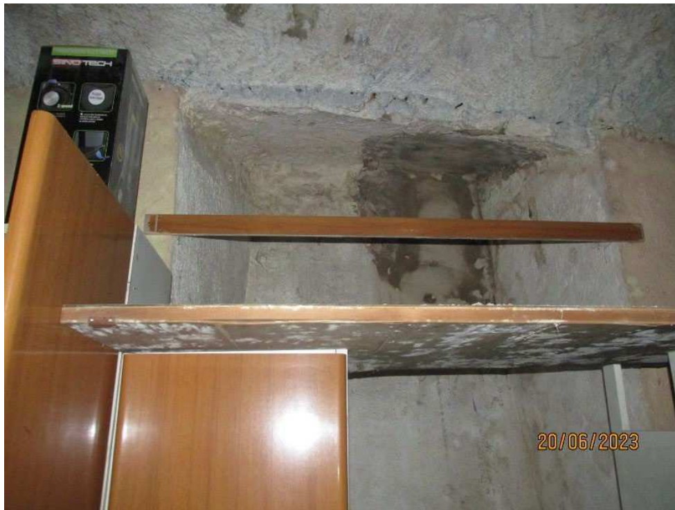
-Fotografia 29 – Locale 4: L’ambiente non dispone di lustriere verso l’esterno, in quanto, probabilmente, quella originariamente esistente è stata murata. Anche in questo caso l’ambiente si presenta in un totale stato di abbandono, occupato da diversi mobili e materiali di ogni genere, le pareti mostrano segni diffusi di efflorescenze di macchia di umidità da risalita, anche il soffitto presenta diffuse macchie di umidità con fenomeni di distacco dello strato superficiale degli intonaci.
