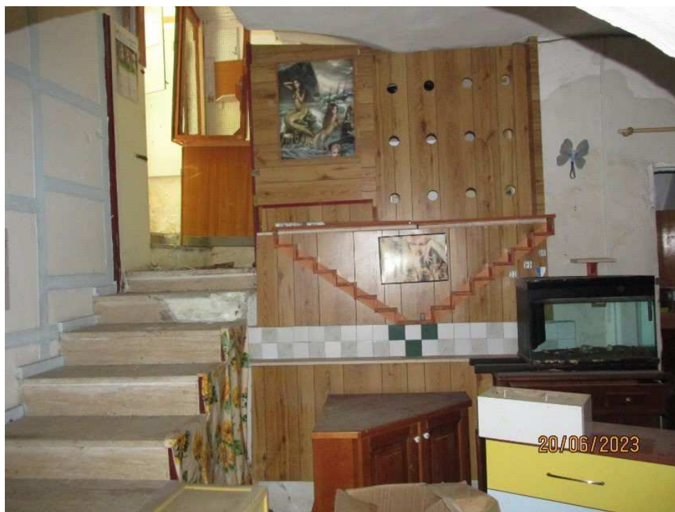
Fotografia 17 – Locale 1: La pavimentazione è costituita da piastrelle in ceramica; le pareti in parte sono rivestite con piastrelle in ceramica smaltata, in parte con doghe in legno e in parte con intonaci ordinari e tinteggiati con pittura lavabile; il soffitto interamente intonacato e tinteggiato con pittura a tempera.
