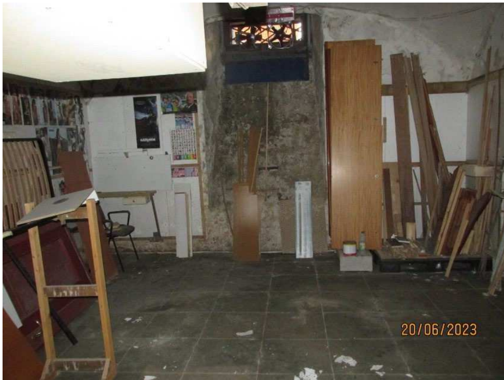
Fotografia 26 – Locale 3: L'ambiente dispone di una lustriera a “bocca di lupo” prospiciente la strada pubblica di Vico Sant'Eframo Vecchio. Anche in questo caso l'ambiente si presenta in un totale stato di abbandono, occupato da diversi mobili e materiali di ogni genere, le pareti mostrano segni diffusi di efflorescenze di macchia di umidità da risalita, anche il soffitto presenta diffuse macchie di umidità con fenomeni di distacco dello strato superficiale degli intonaci.
