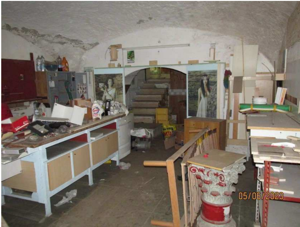
Fotografia 21 – Locale 2: La pavimentazione è costituita da piastrelle in ceramica; le pareti sono rivestite con intonaci ordinari e tinteggiati con pittura lavabile; il soffitto è costituito da una volta a “vela”, rivestito con intonaco grezzo non rifinito e tinteggiato con pittura a tempera.
