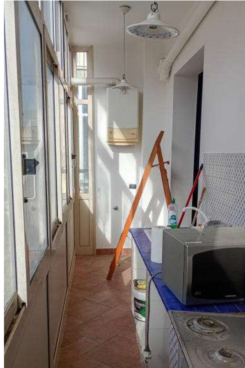
Balcone nel retroprospetto chiuso a veranda
