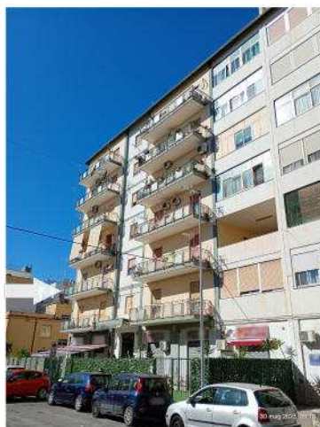
Ubicazione dell'immobile pignorato
