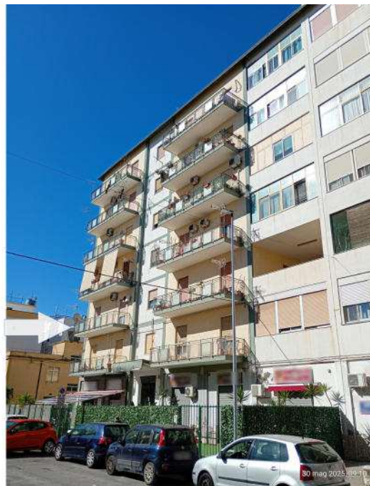
Ubicazione dell'immobile pignorato
