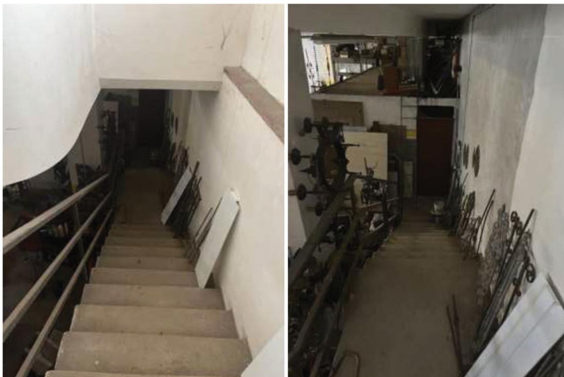
Figg.16-17 – Vista su vano scala di raccordo tra piano terra e piano seminterrato
