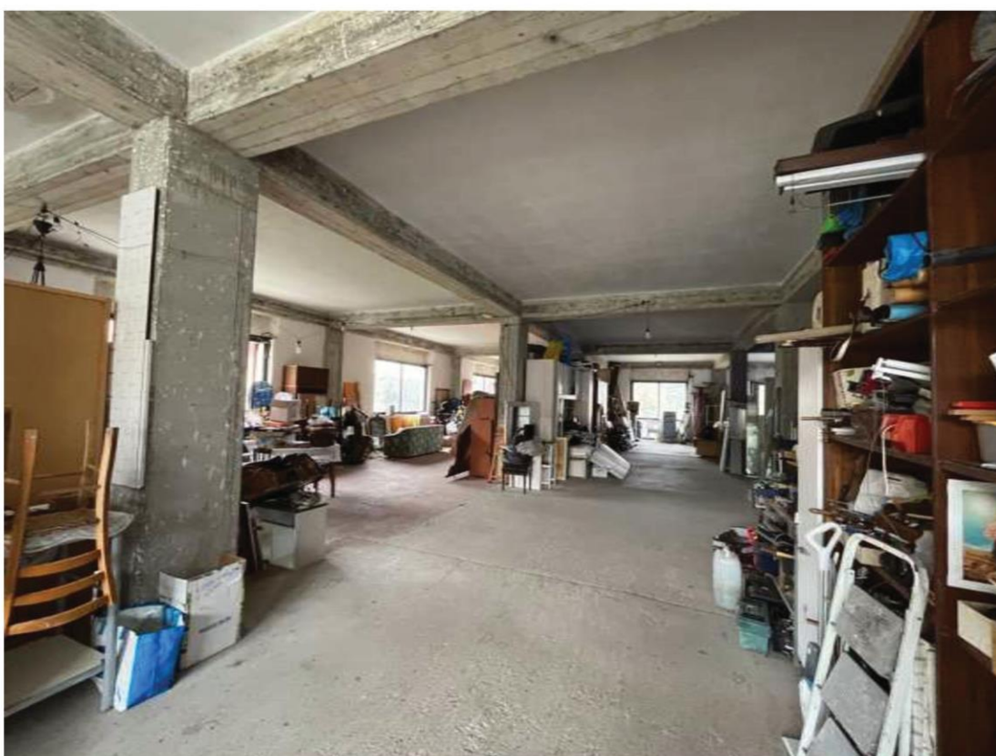
Fig.6 – Vista dall'interno del vano open space posto al Piano Terra
