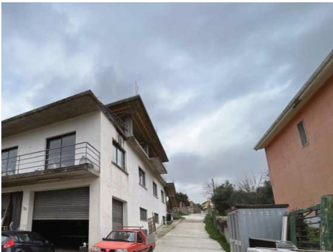
Fig.34 – Vista su percorso di accesso al piazzale posteriore
