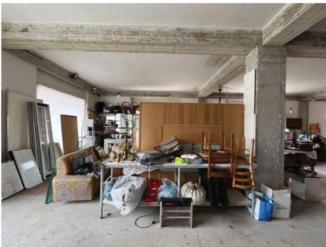
Fig.8 – Vista dall'interno del vano open space posto al Piano Terra
