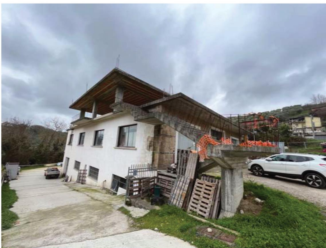
Fig.35 – Vista laterale su immobile con individuazione del sub.5 in fase di costruzione posto al primo piano
