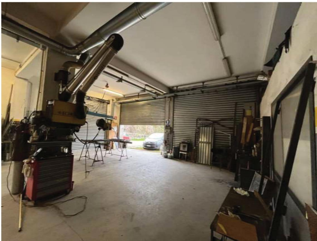
Fig.29 – Vista su serrande d'ingresso del piano seminterrato
