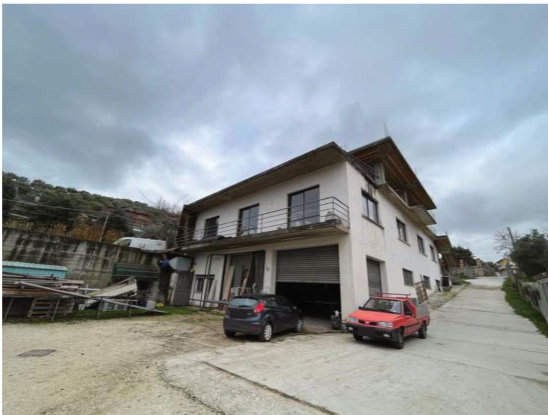
Fig.30 – Vista esterna dell'immobile da sud est verso nord-ovest
