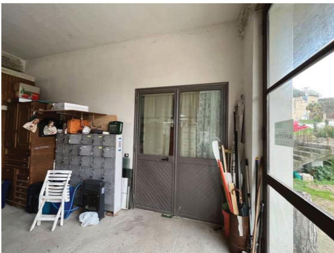
Fig.12 – Vista ingresso area adibita a zona uffici posta al PT
