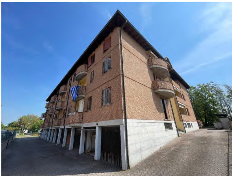
Foto 2 - Prospetto Ovest– Ingresso Garage
