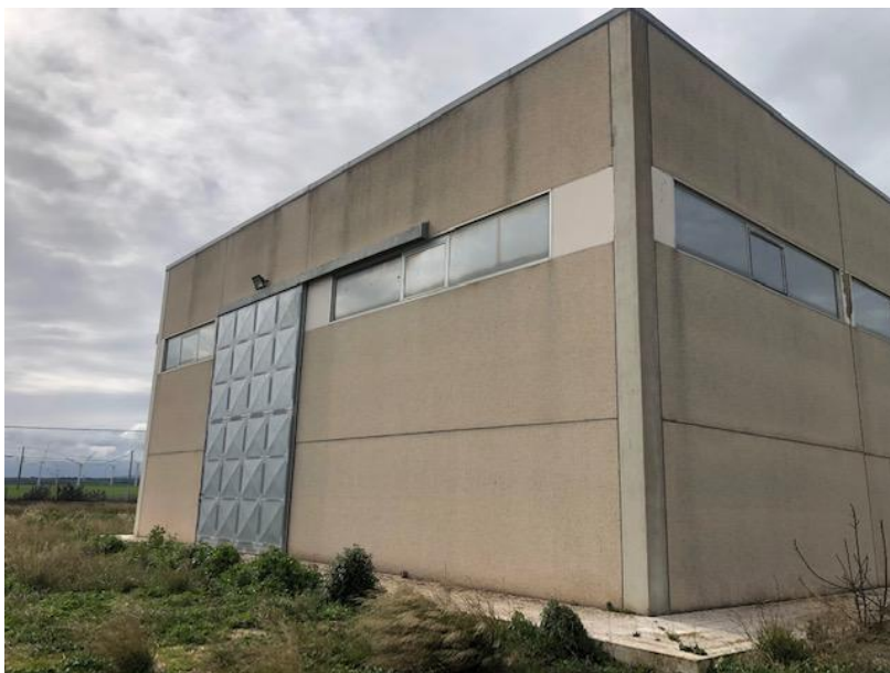
lato est del capannone
