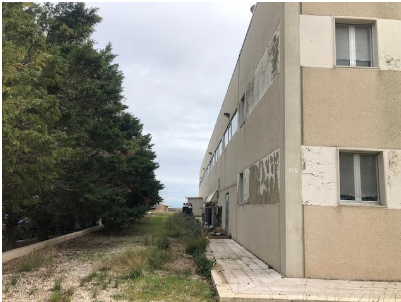
Vertice nord ovest del capannone
