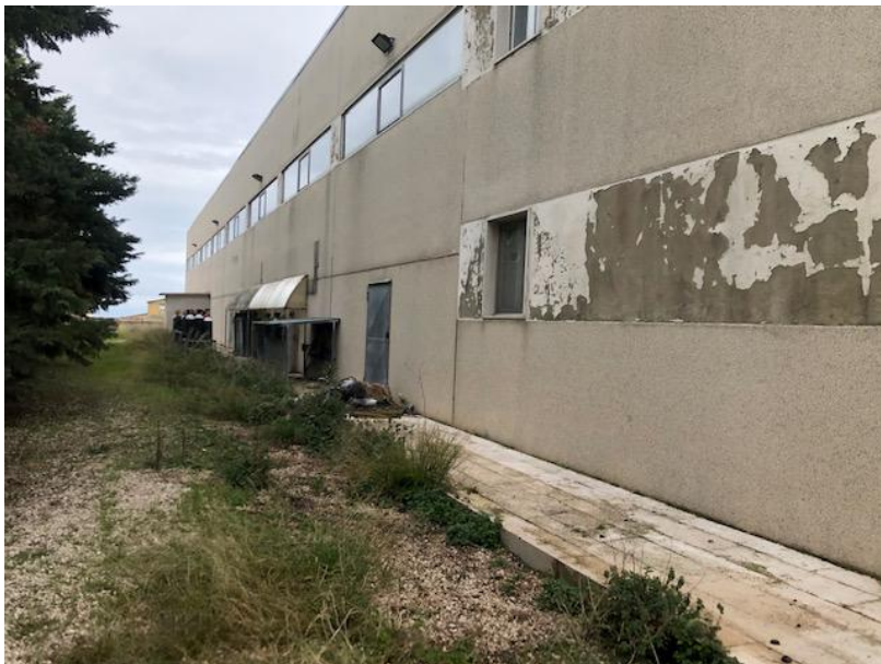
lato nord del capannone
