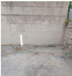
n. 19 - FG. 67 p.lla 988 sub 19
