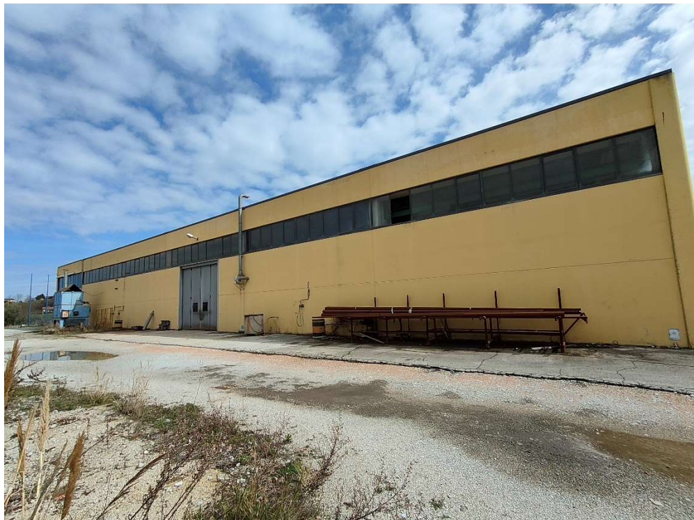
Foto 4- Vista del Capannone Industriale da corte interna
