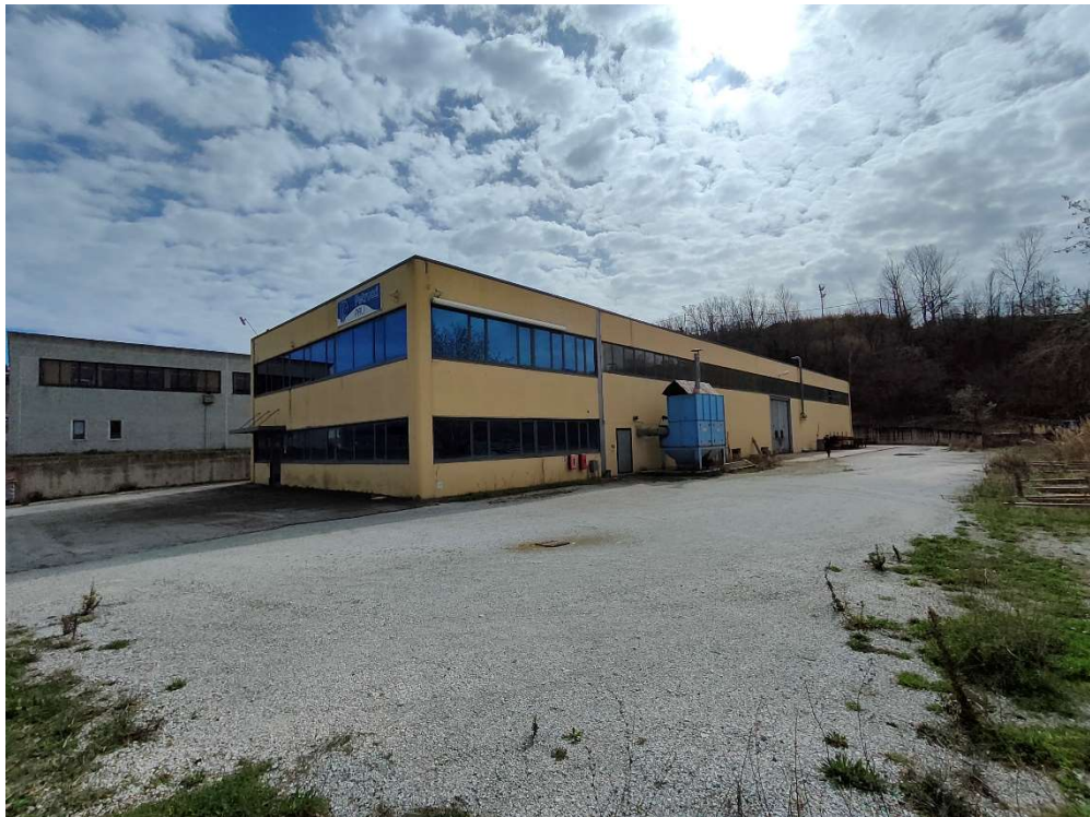
Foto 3- Vista del Capannone Industriale da corte interna
