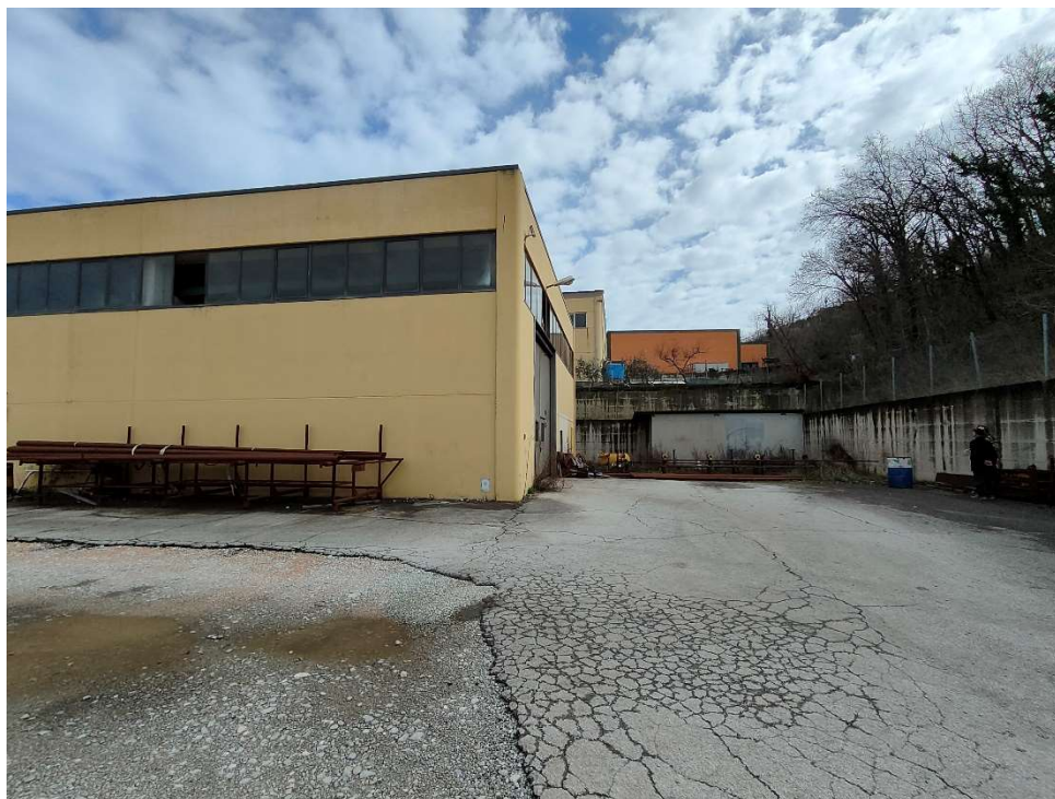
Foto 5- Vista del Capannone Industriale da corte interna
