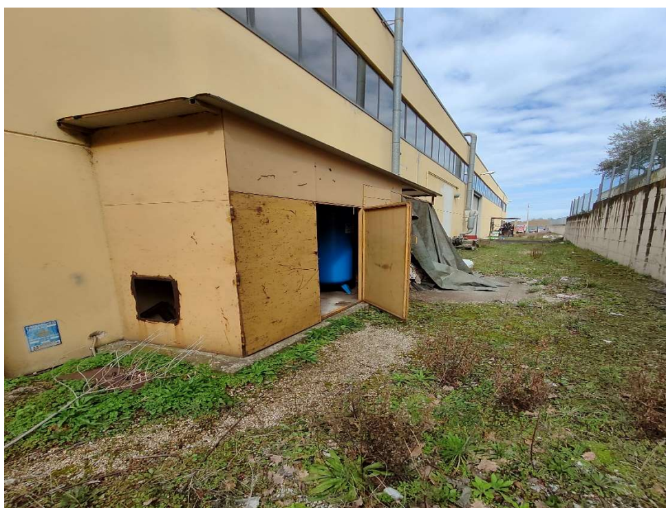
Foto 6- Vista del Capannone Industriale da corte interna
