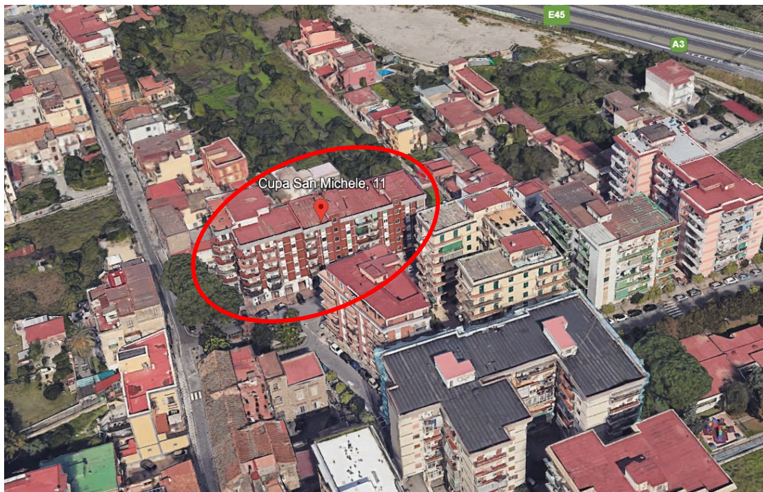
Fabbricato in San Giorgio a Cremano (NA) alla Via Cupa San Michele n. 11
