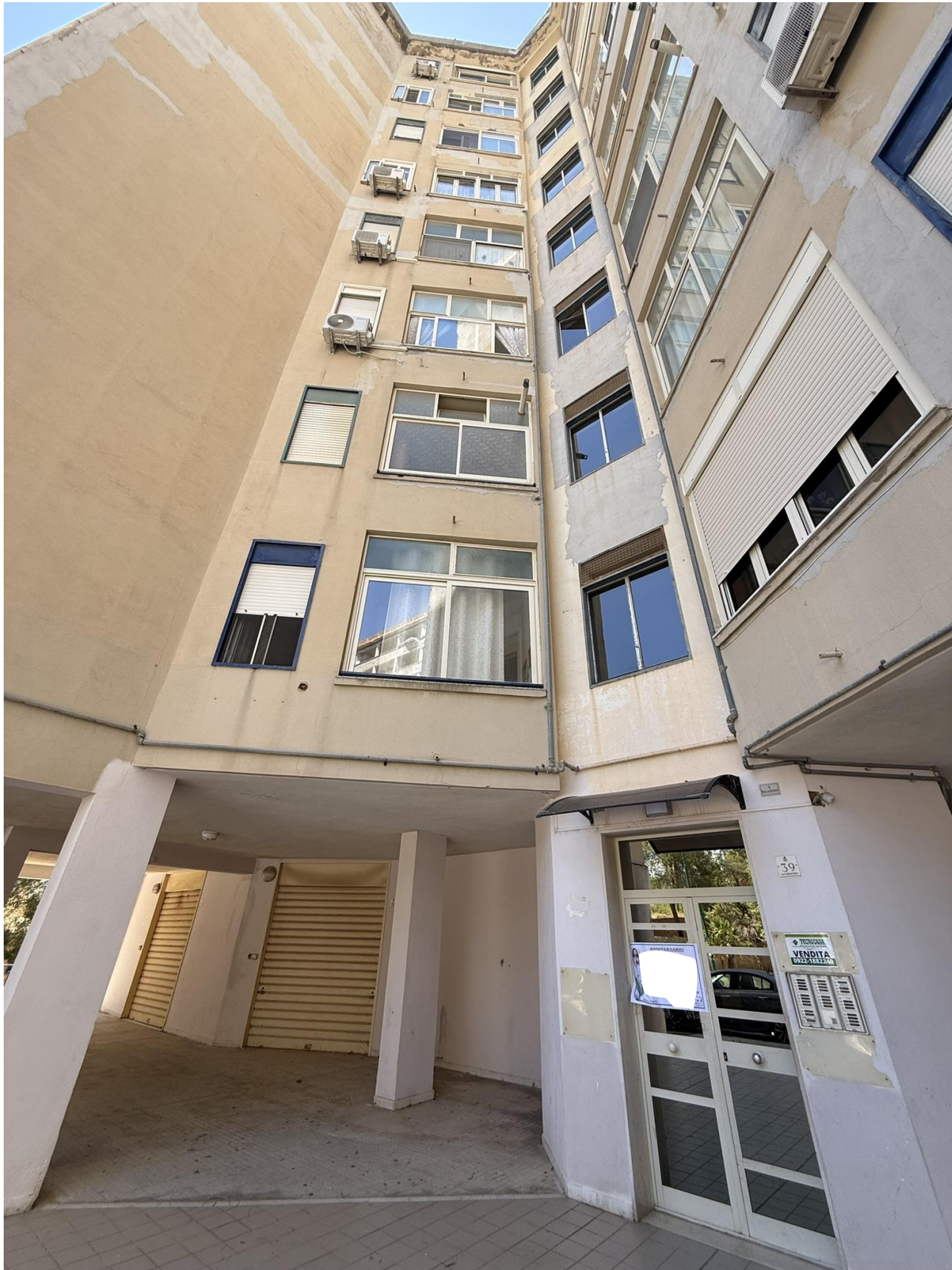
Foto 2 – Prospetto esterno ingresso stabile
