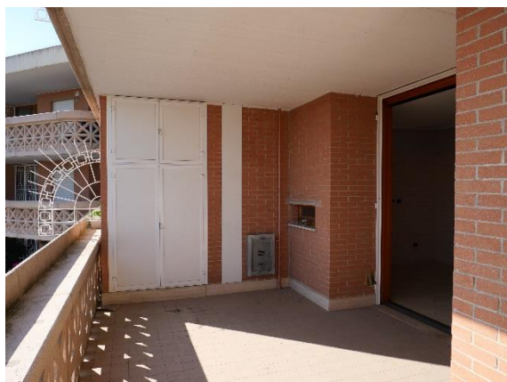
Balcone lato locale caldaia e boiler
