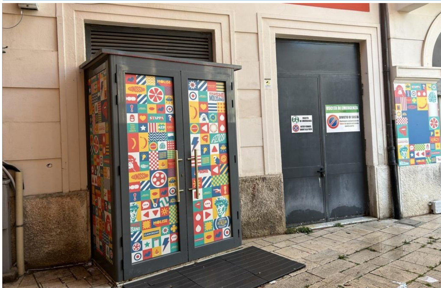
Ingresso all'attività commerciale e uscita di sicurezza teatro - Piano terra sub.66 e 67
