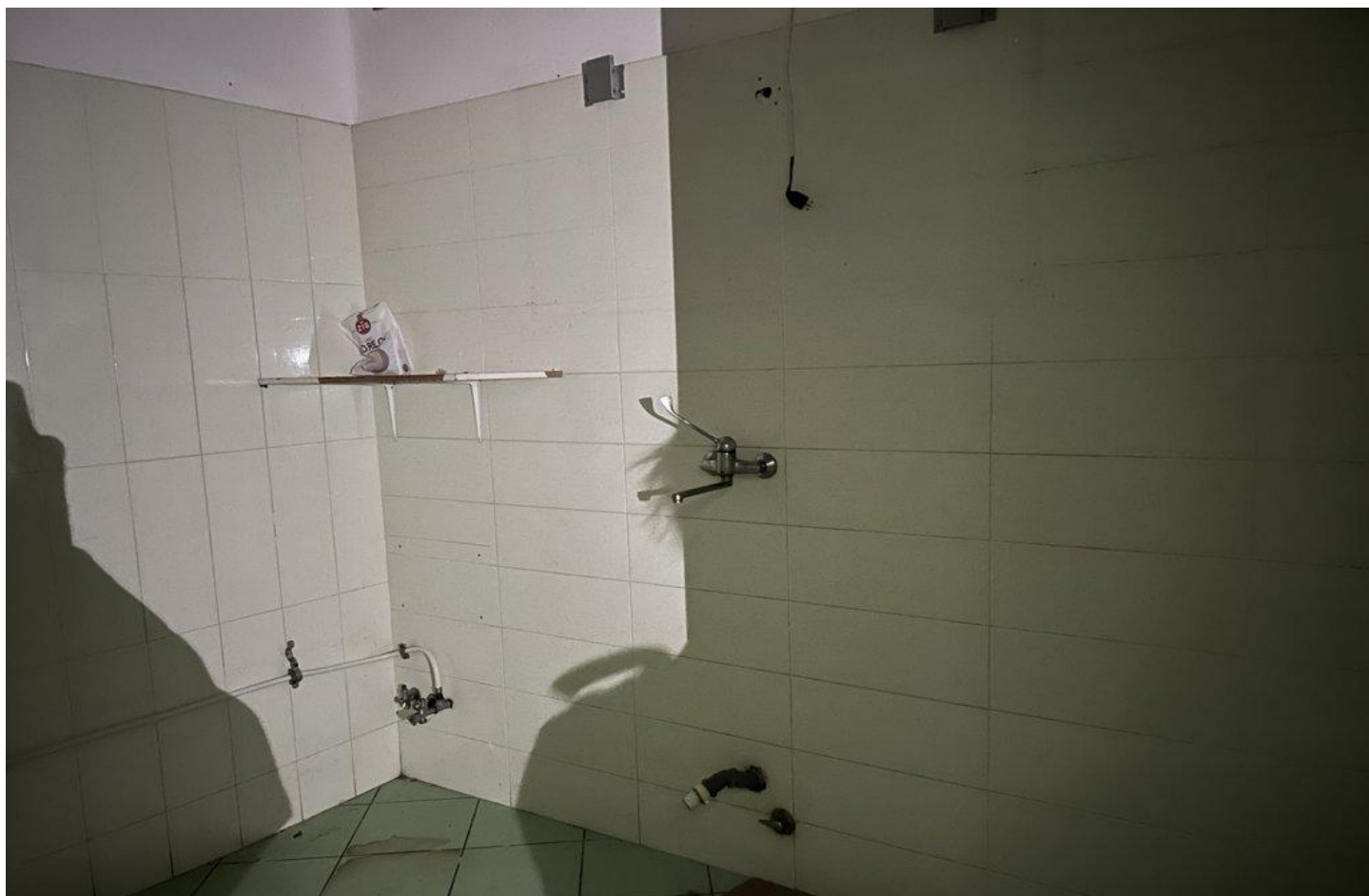
zona lavaggio - Piano interrato sub.66
