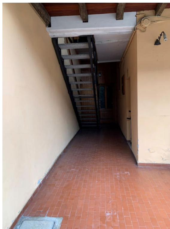
Passaggio comune al P.T. sub 710
