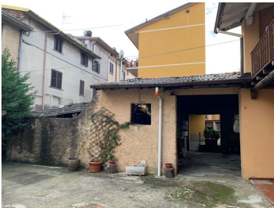
Magazzino posto in fondo alla corte sub 711
