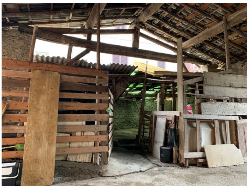
Interno al magazzino
