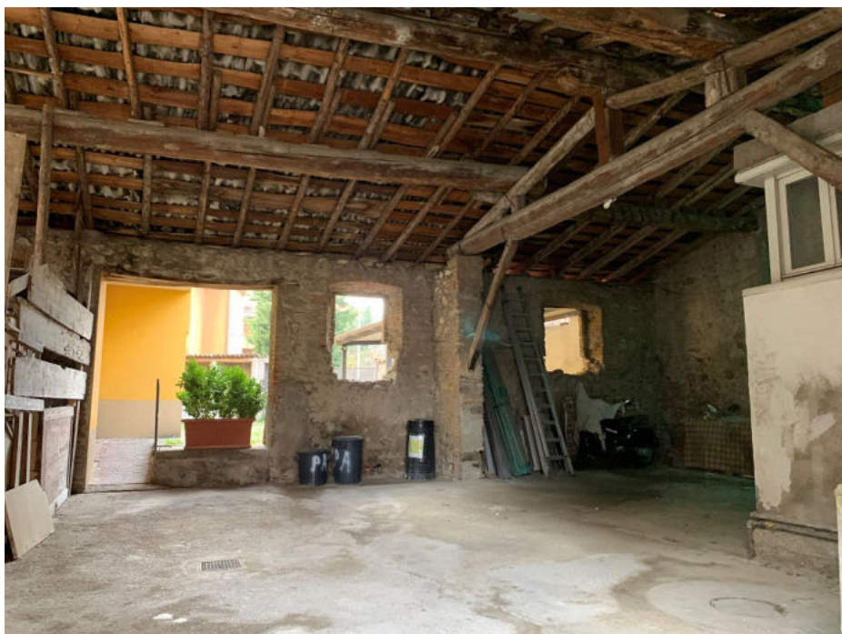
Interno al magazzino
