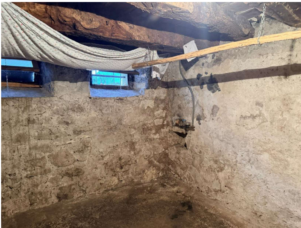
Foto 04: PS1 cantina lato Ovest
