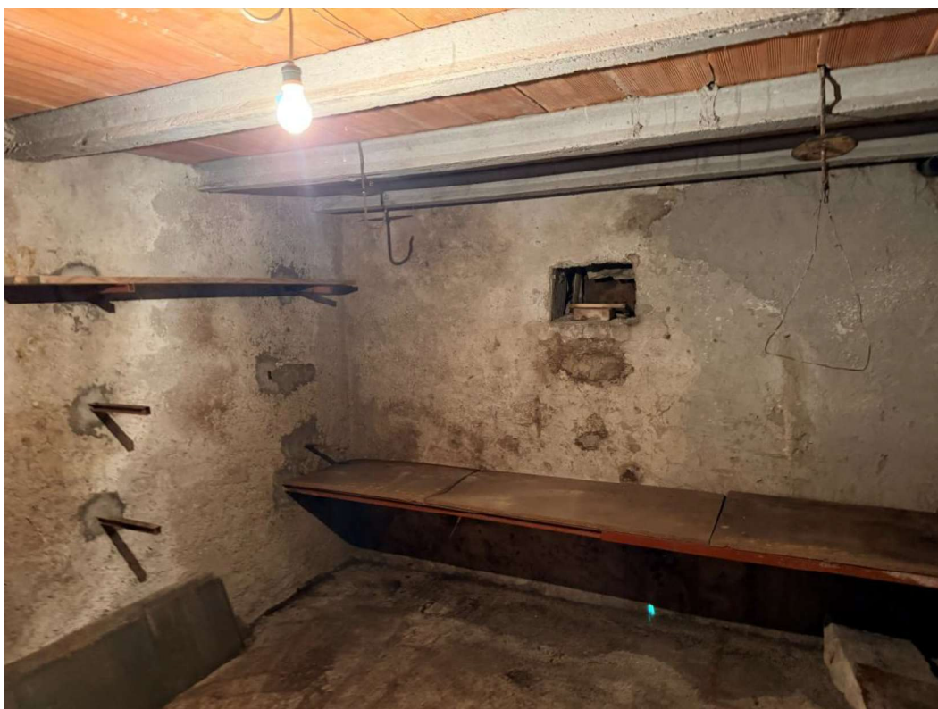
Foto 05: PS1 cantina lato Est (sopra si trova la cucina)
