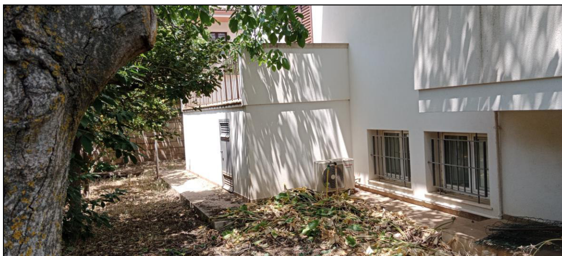
Foto 4 Esterno lato sud
