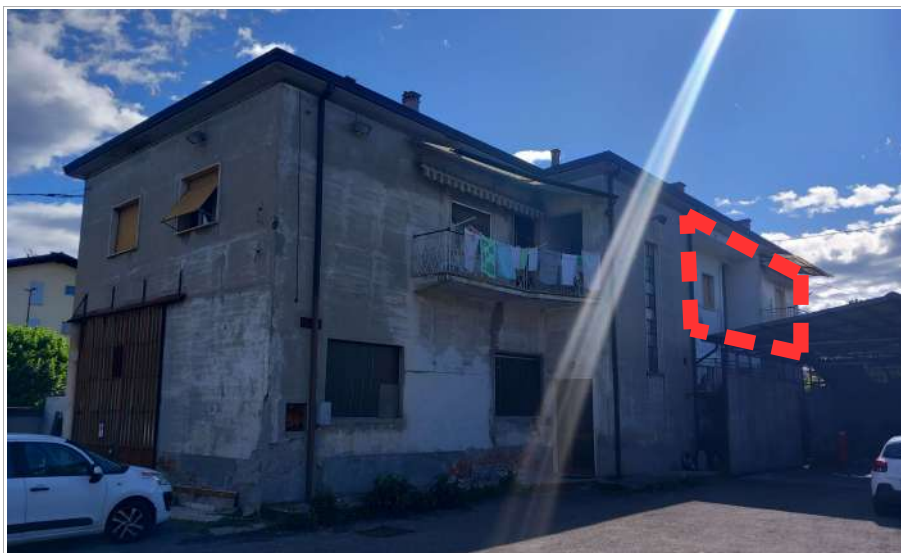
Foto 3: Vista da ovest (dal via Circonvallazione) con individuazione dell'unità oggetto del pignoramento.
