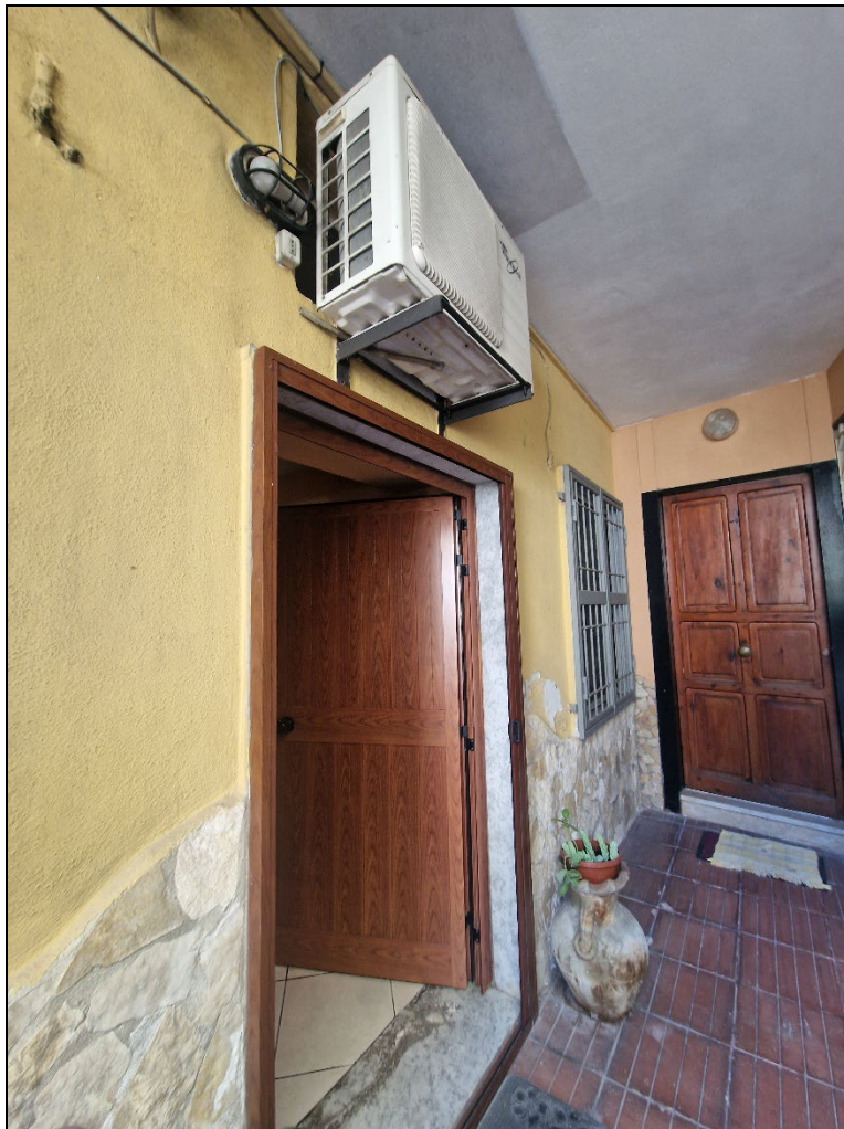
Foto 5: vista dell'ingresso esclusivo al Sub. 13 esecutato.
