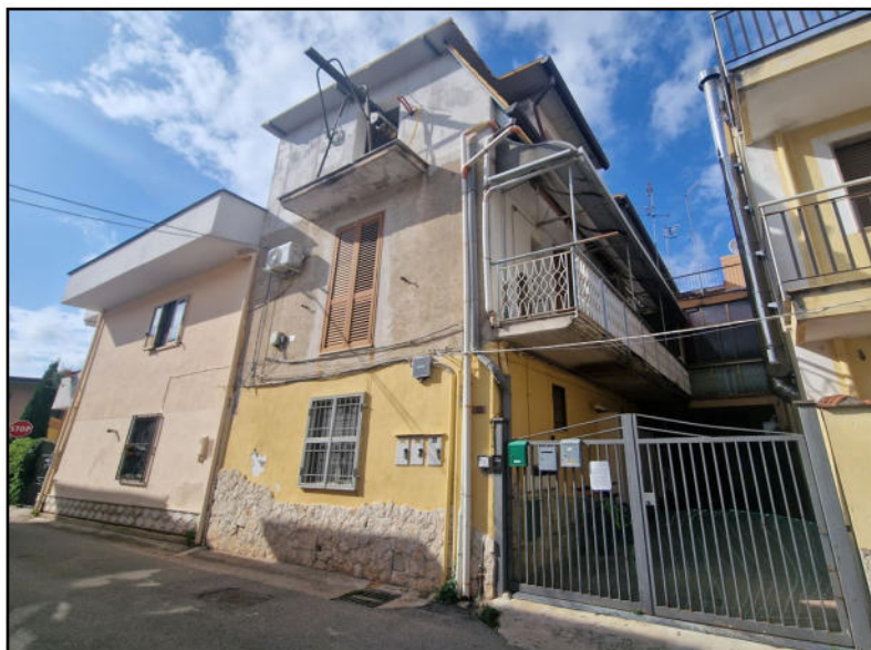
Foto 2: vista del Fabbricato di ricaduta P.Illa 398, in corrispondenza del civ. 12 di Via Pisano.
