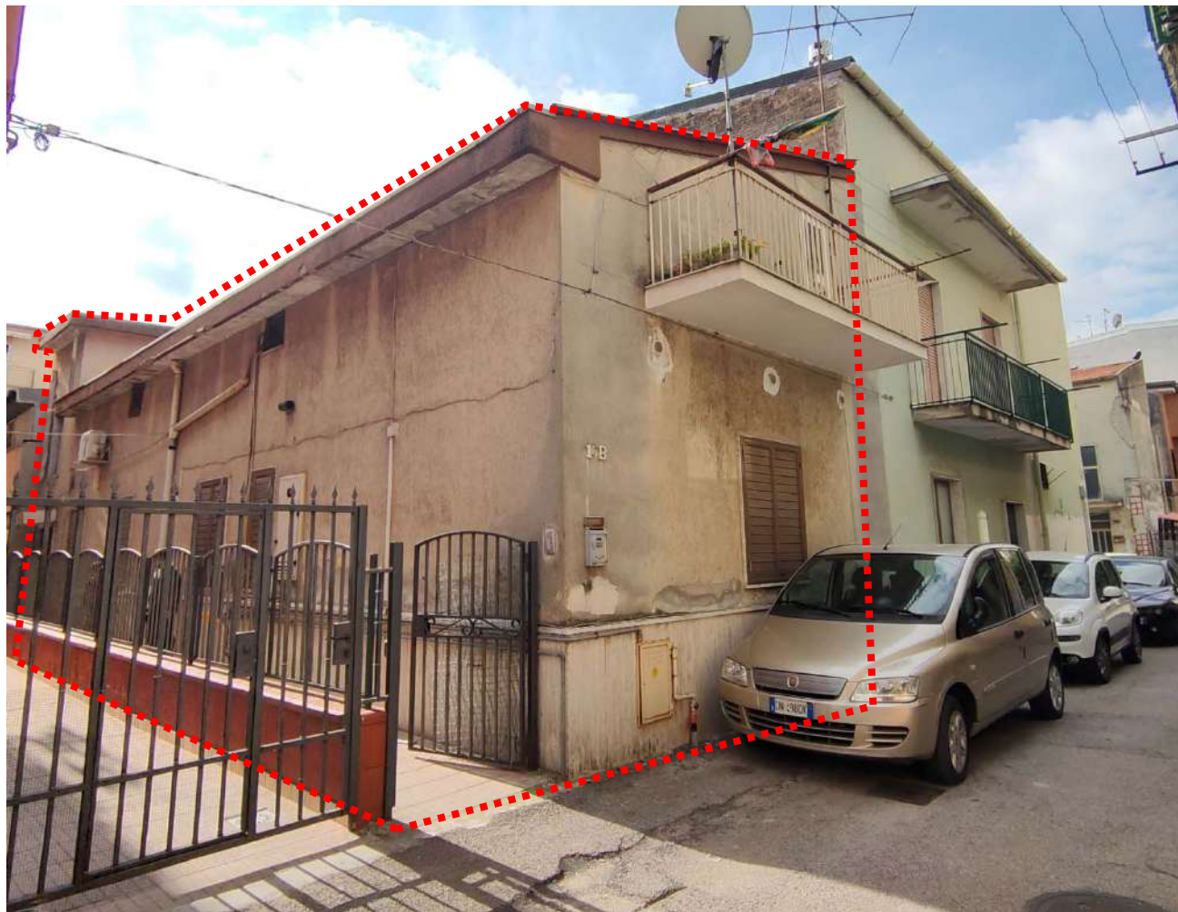
Fabbricato unifamiliare - LOTTO 1 – con vialetto di accesso da Traversa via Archimede
