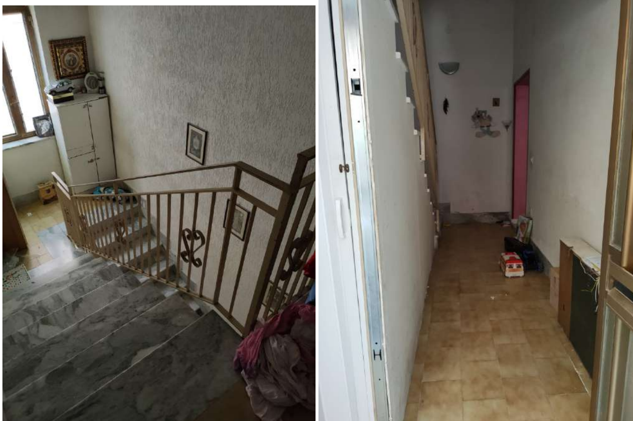
FOTO 5 - 6 - 7: INGRESSO PRINCIPALE AL FABBRICATO CON DISIMPEGNO E VANO SCALA DI COLLEGAMENTO CON IL PIANO SOTTOTETTO E PORTA DI INGRESSO AL PIANO TERRA. RISULTA PRESENTE SOTTO LA PRIMA RAMPA DI SCALE UN VANO DEPOSITO DI RIDOTTE DIMENSIONI.
