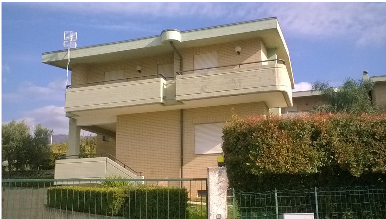
Foto Fabbricato, Gizzeria, F.22, p.lla 613, sub.4, ctg. A/7, vani 6, piano S1-T-1, lato Ovest
