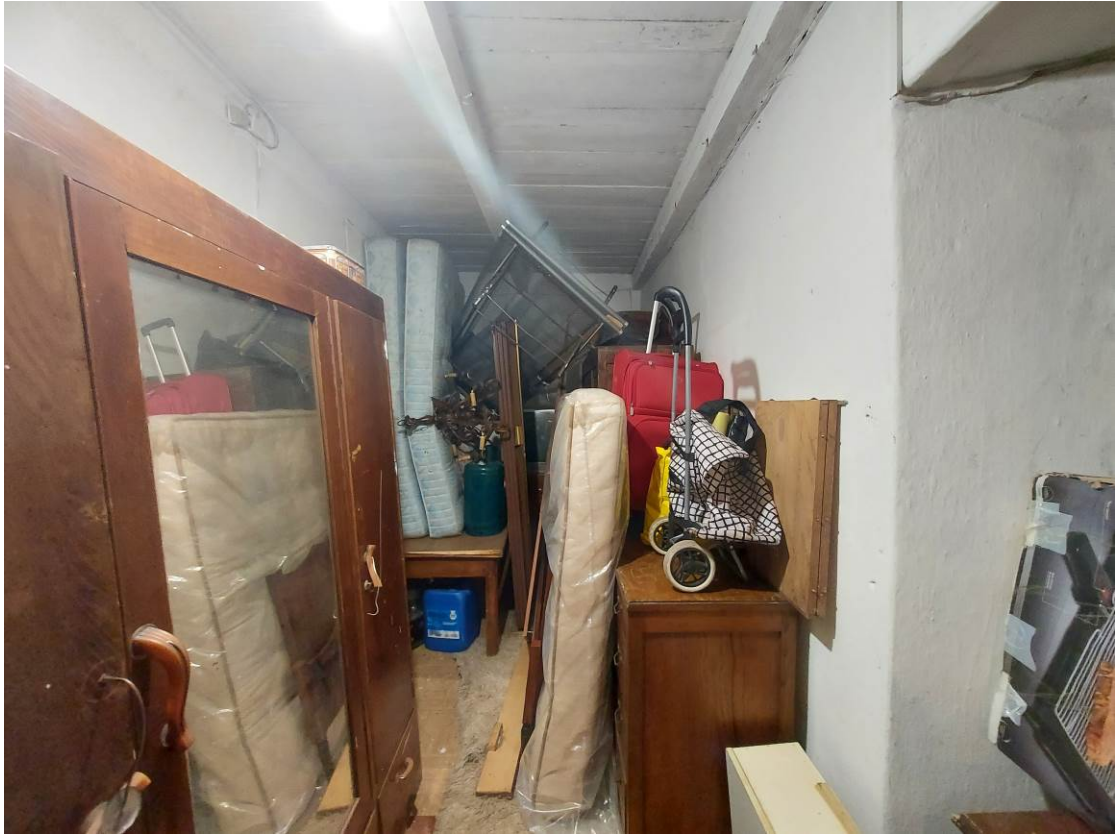
Vista interna - Disimpegno
