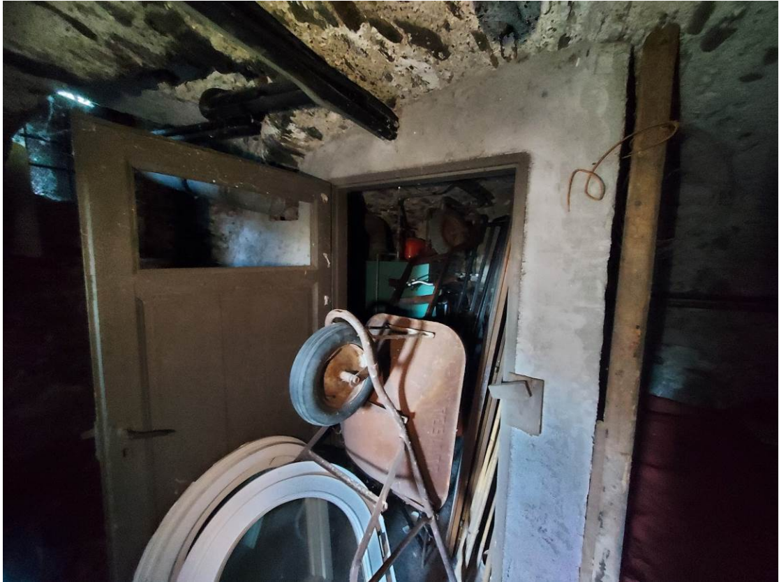
Vista interna – Ripostiglio piano terra
