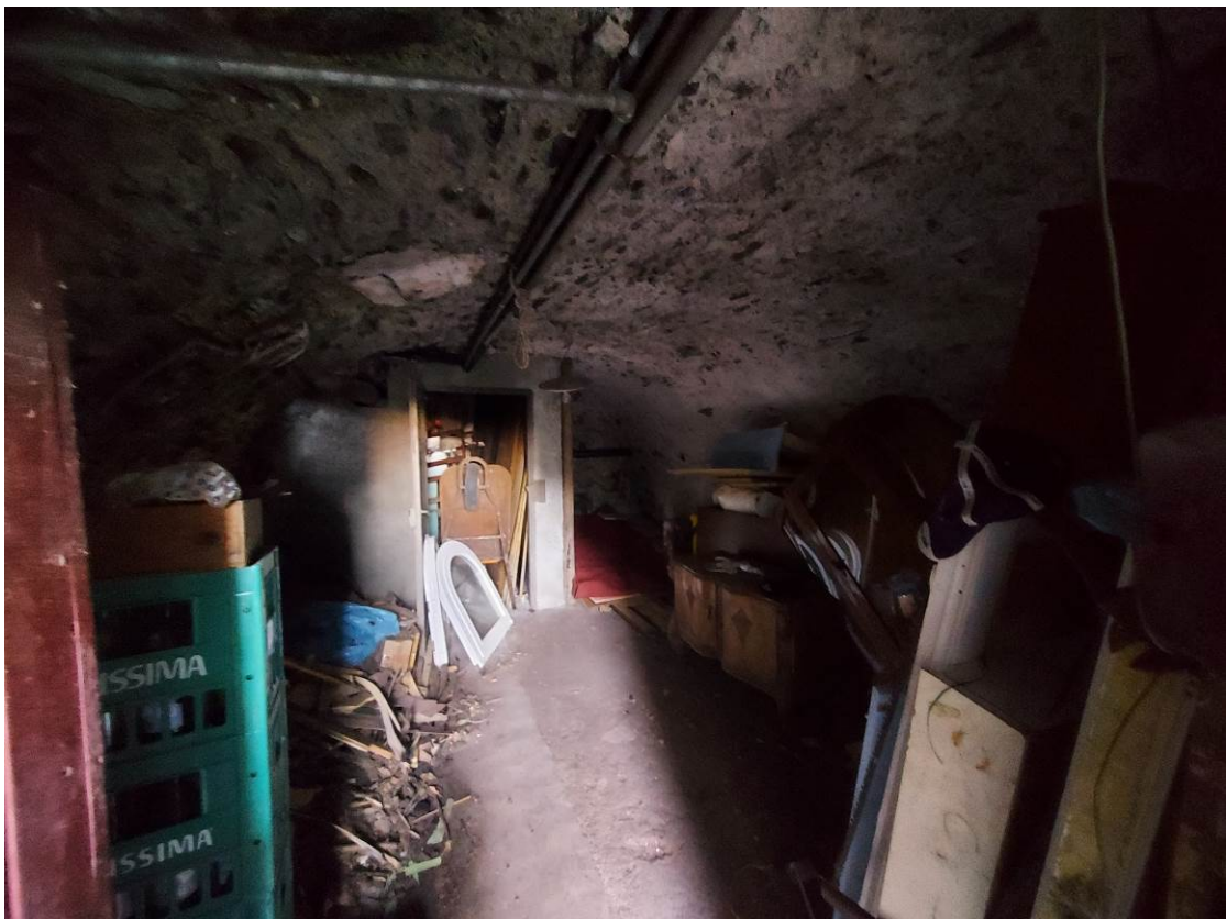
Vista interna – Ripostiglio piano terra
