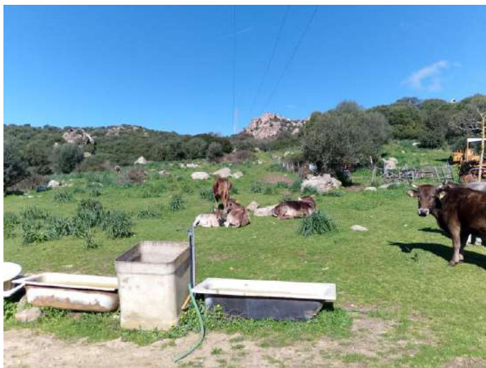
Foto n. 3 – 4 - 5: Vista del traliccio dell'alta tensione presente a valle del lotto e vista generale dell'area agricola a valle
