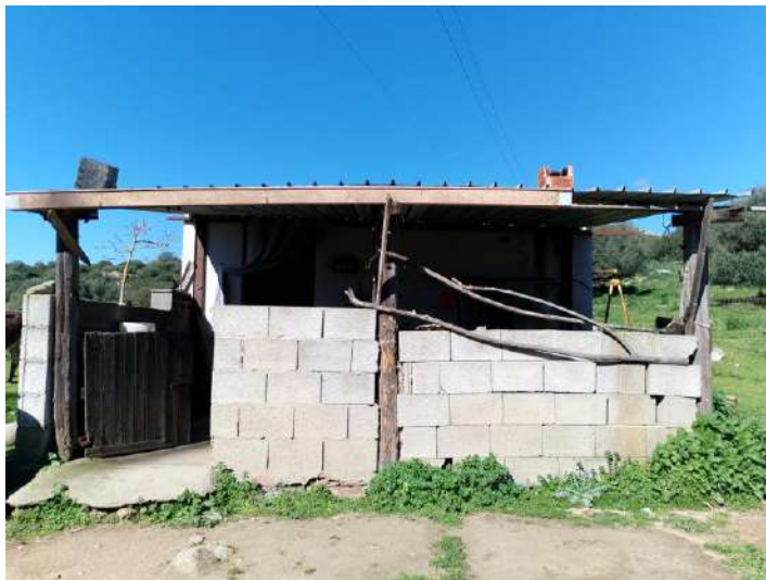
Foto n. 10: Vista fronte ingresso veranda locale deposito
