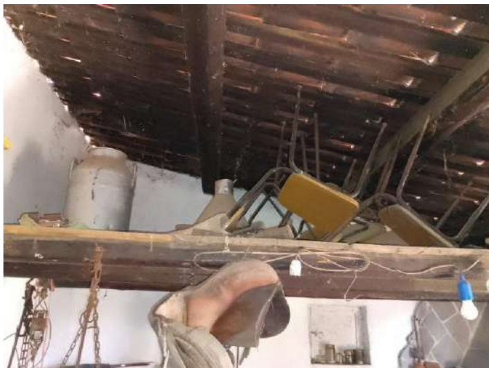
Foto n. 22: Vista intradosso solaio di copertura locale deposito
