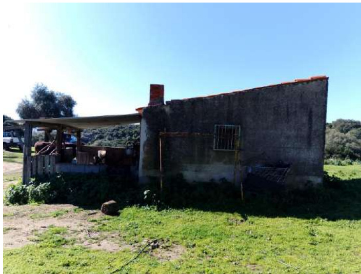
Foto n. 11: Vista prospetto laterale destro
