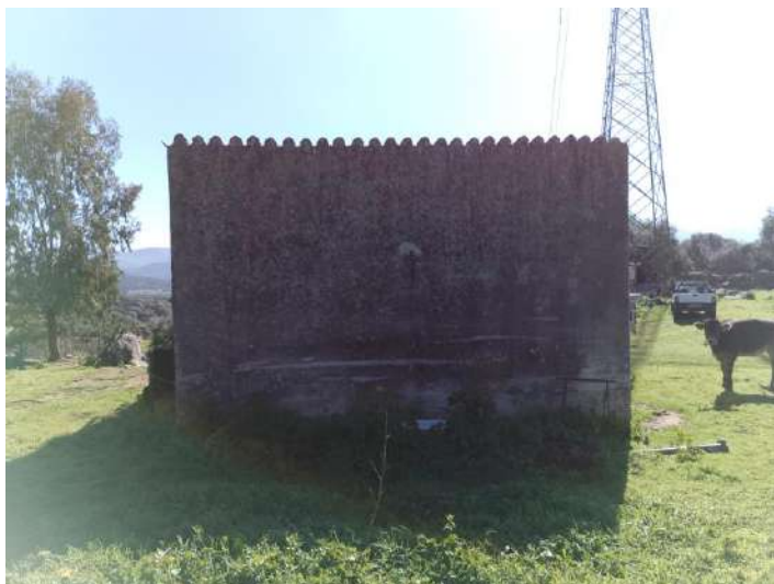
Foto n. 12: Vista prospetto retro deposito
