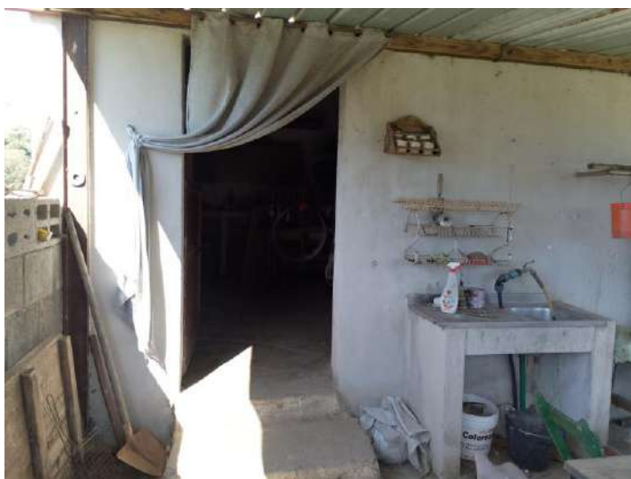
Foto n. 14: Vista ingresso locale deposito da veranda
