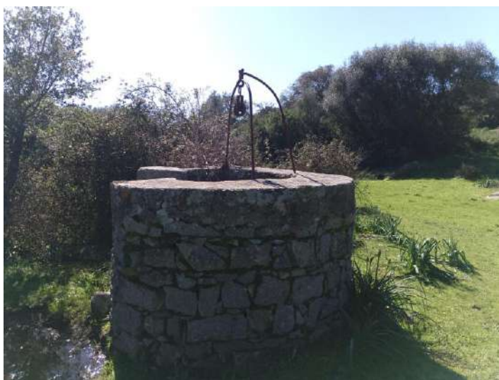
Foto n. 6 - 7: Vista del pozzo esterno realizzato in blocchi di granito
