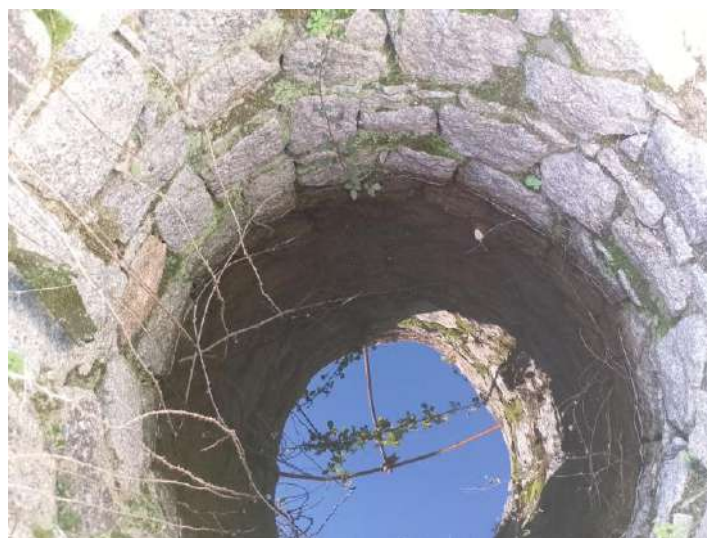
Foto n. 6 - 7: Vista del pozzo esterno realizzato in blocchi di granito
