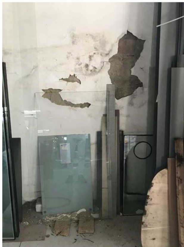
Foto 1 (Vista parete interna capannone)
