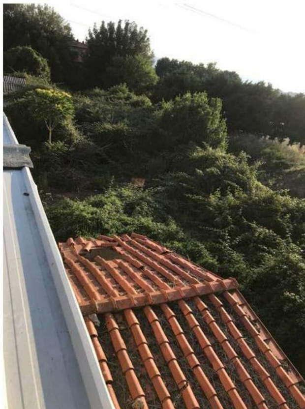
Foto 5 (Vista esterna manufatto e vegetazione)
