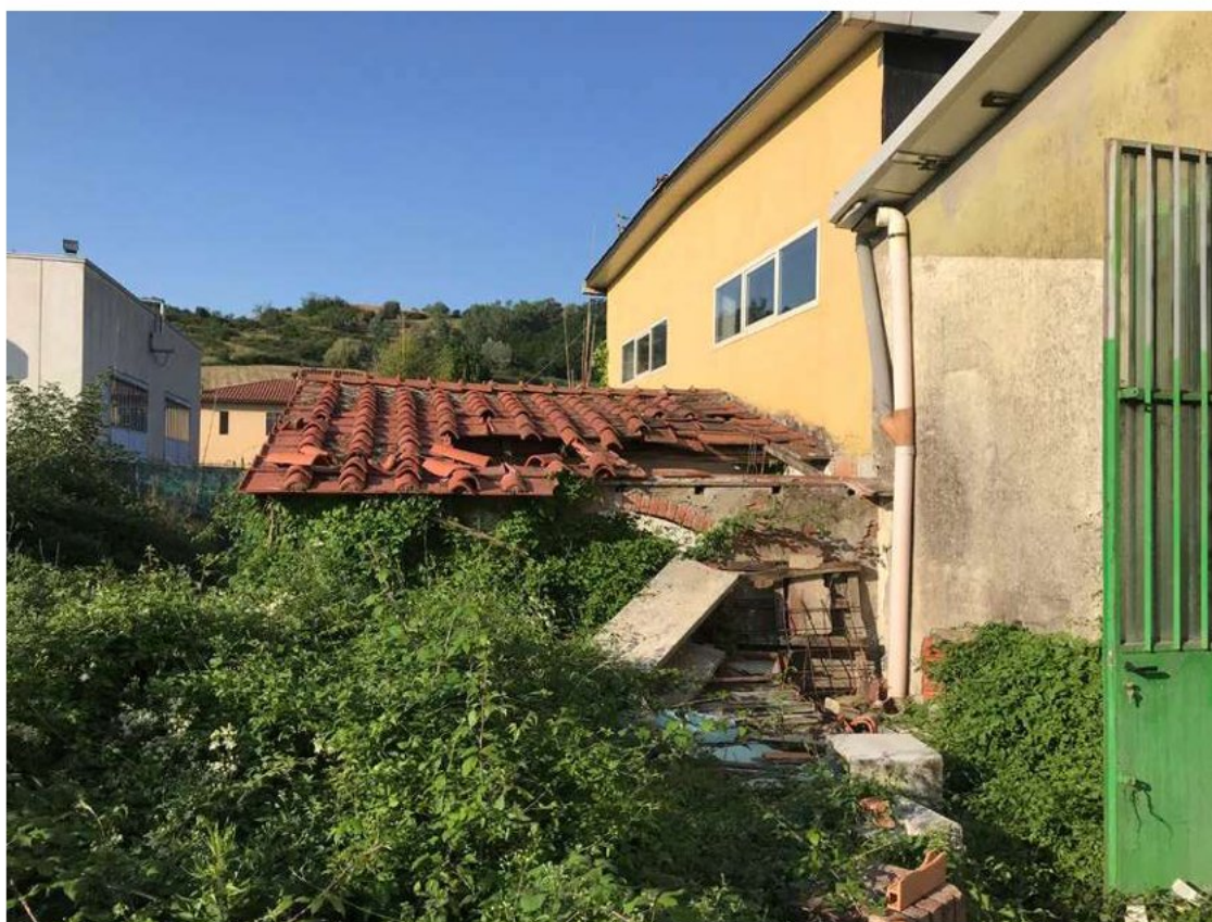
Foto 2 (Vista esterna manufatto e vegetazione)
