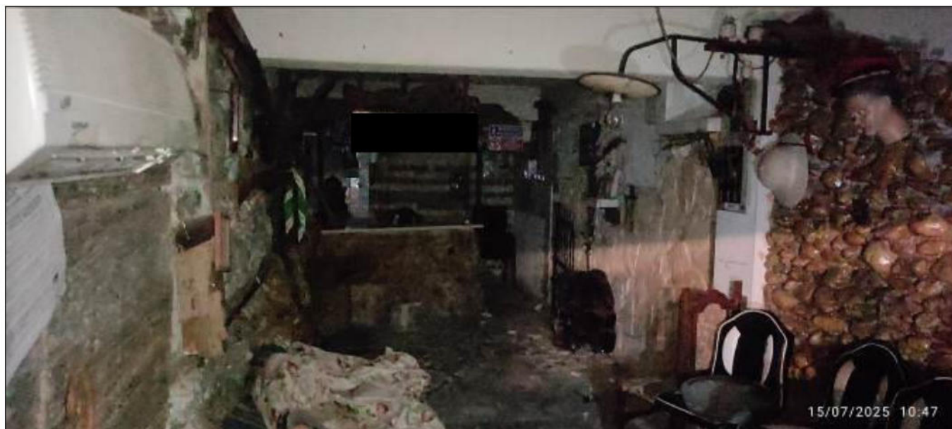
Foto 24 – Interno del sub. 131
