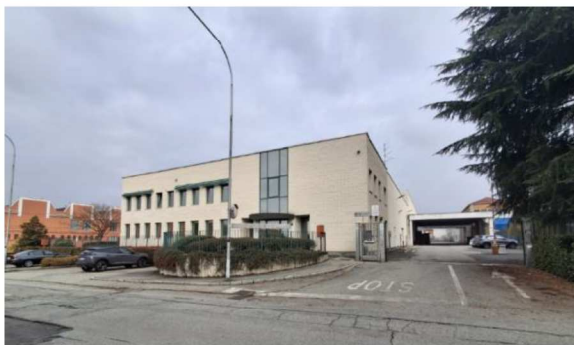
vista del fabbricato industriale da Via Padre Greggio
