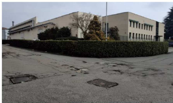
vista del fabbricato industriale da Strada Campagnè
