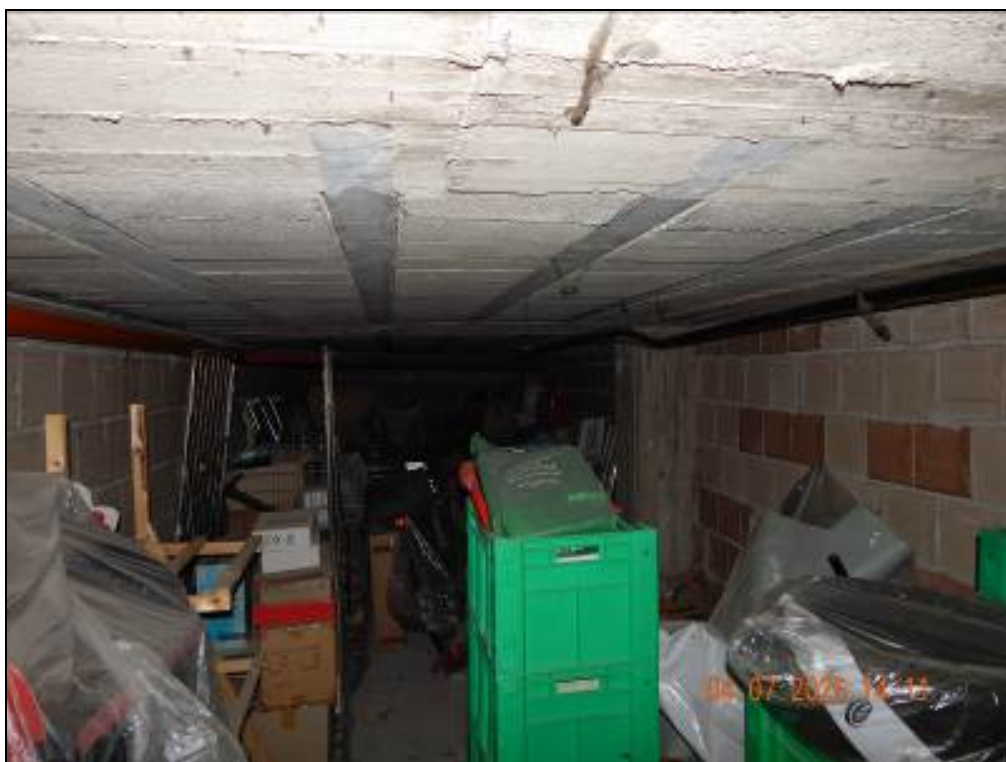
Foto 26 – Interno del sub. 133
