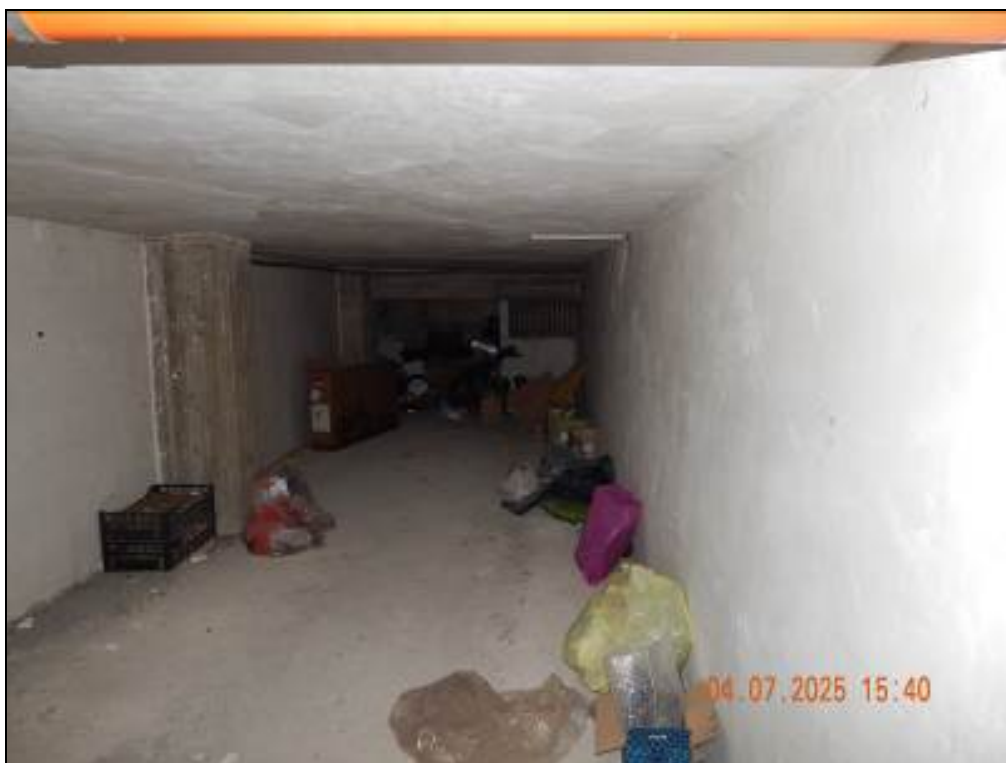
Foto 25 – Interno del sub. 132
