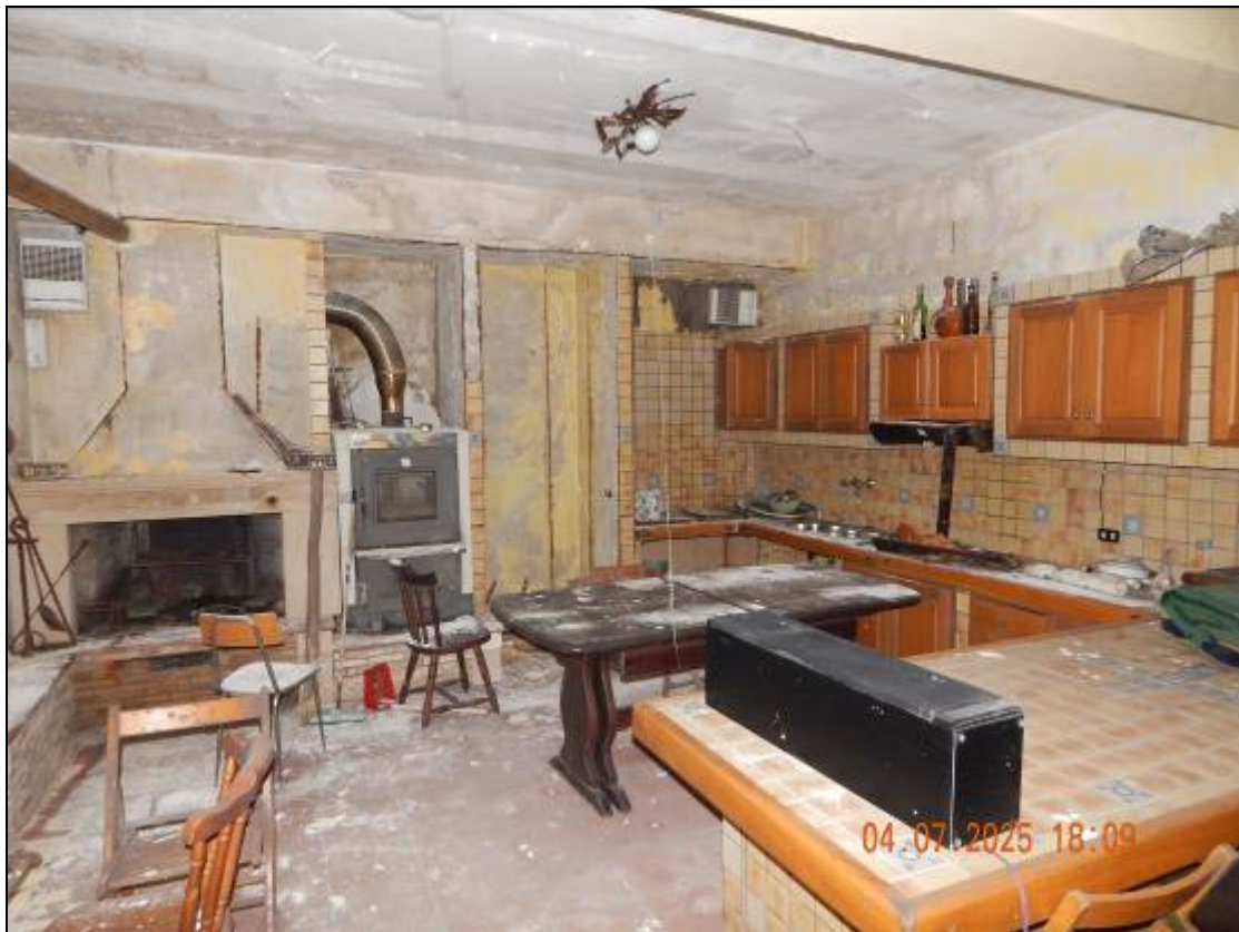
Foto 13 – Veduta di una zona del magazzino
