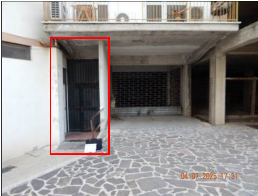
Foto 11 – Vista dell'ingresso al sub. 112 evidenziato in rosso
