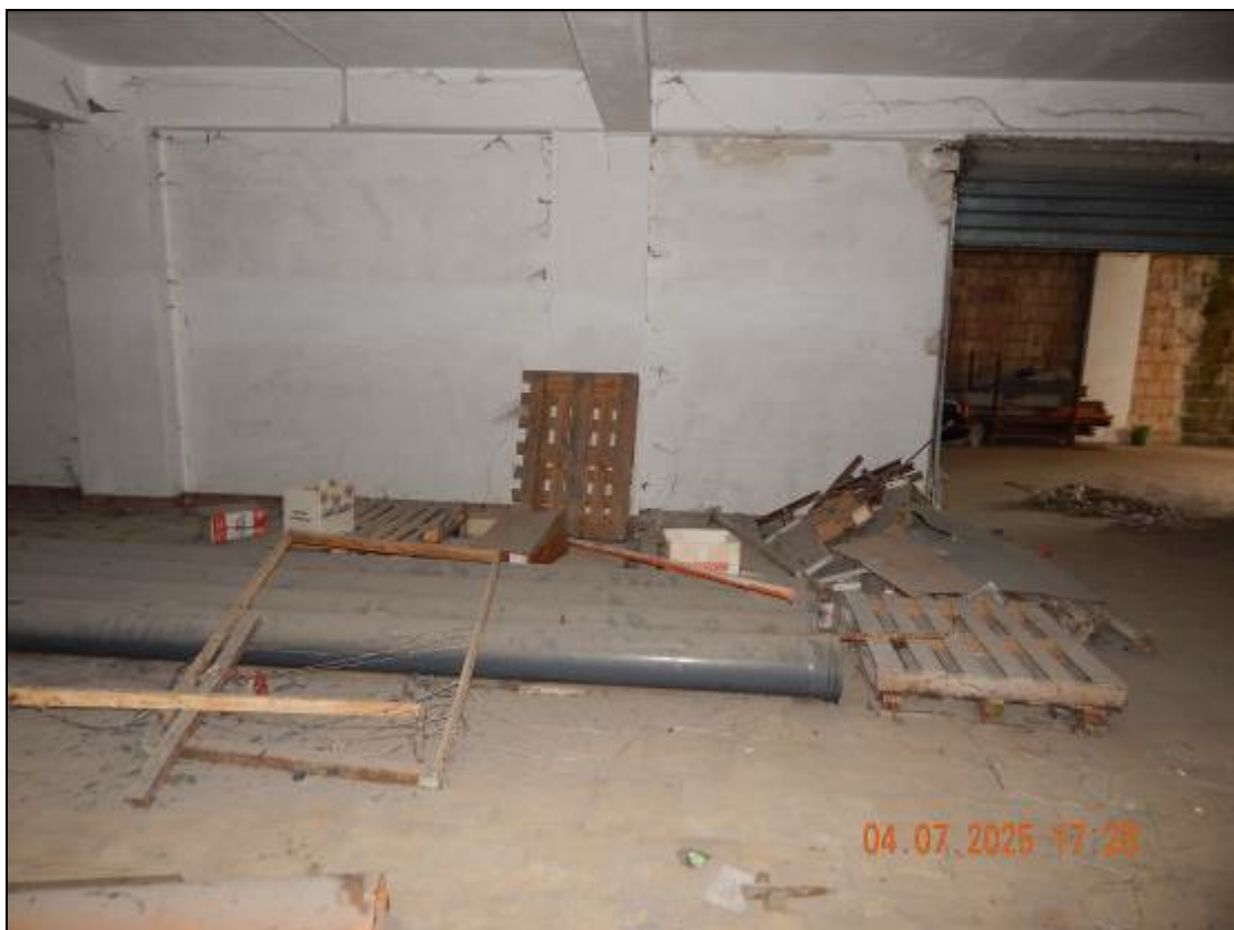
Foto 6 – Zona del magazzino con accesso al Sub. 113.
