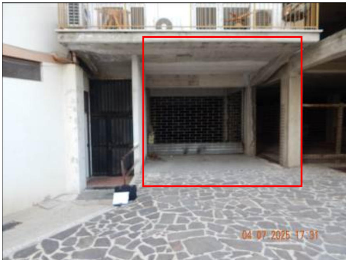
Foto 18 – Vista dell'ingresso al sub. 113 con la sua corte esclusiva
