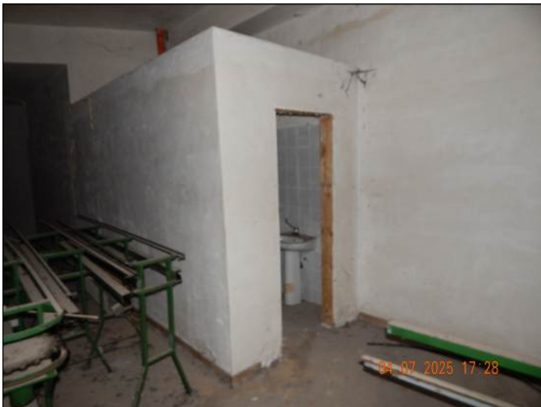
Foto 7 – Veduta del magazzino con posizionamento dei servizi igienici
