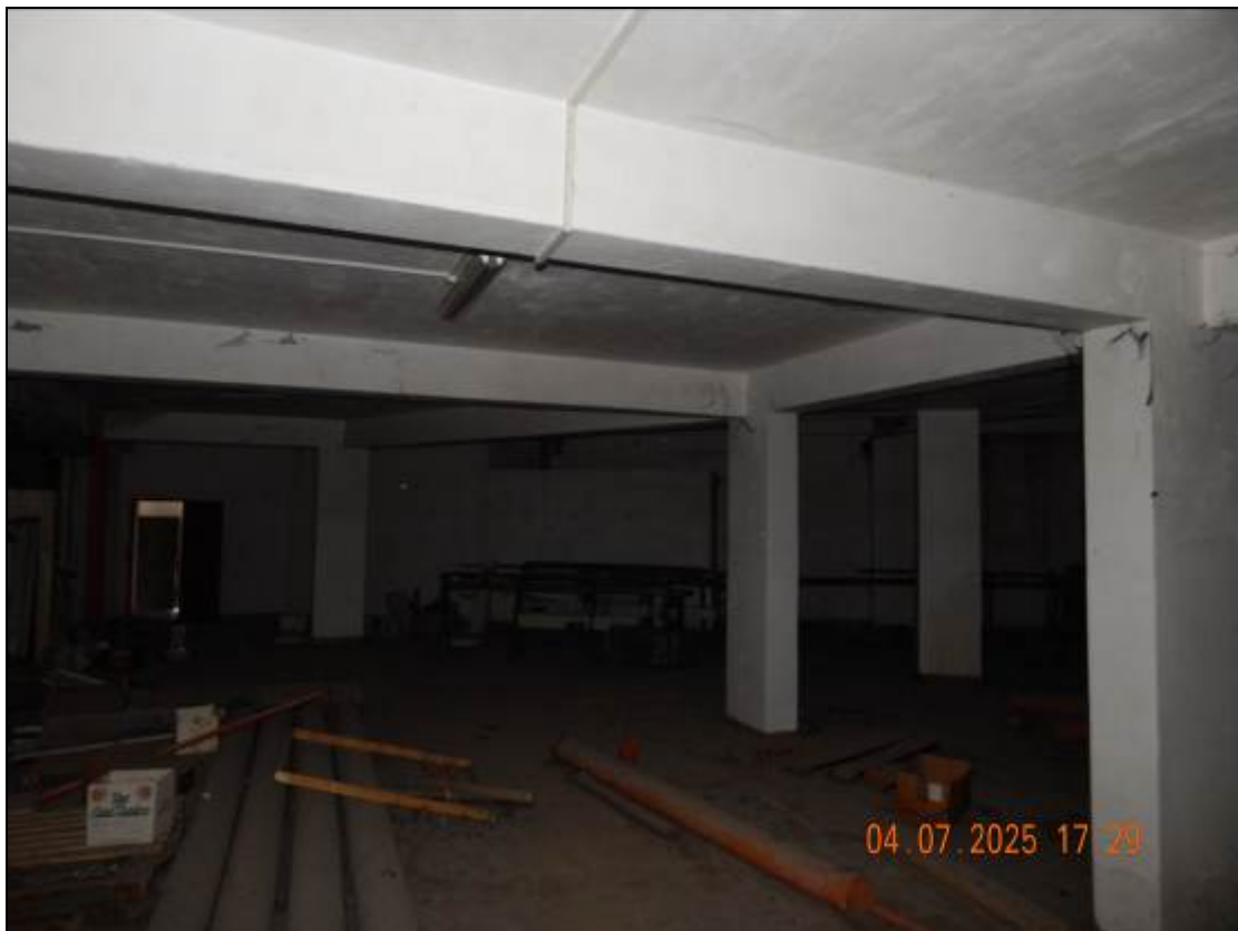
Foto 5 – Magazzino ed in fondo a sinistra la porta di ingresso dalla scala condominiale
